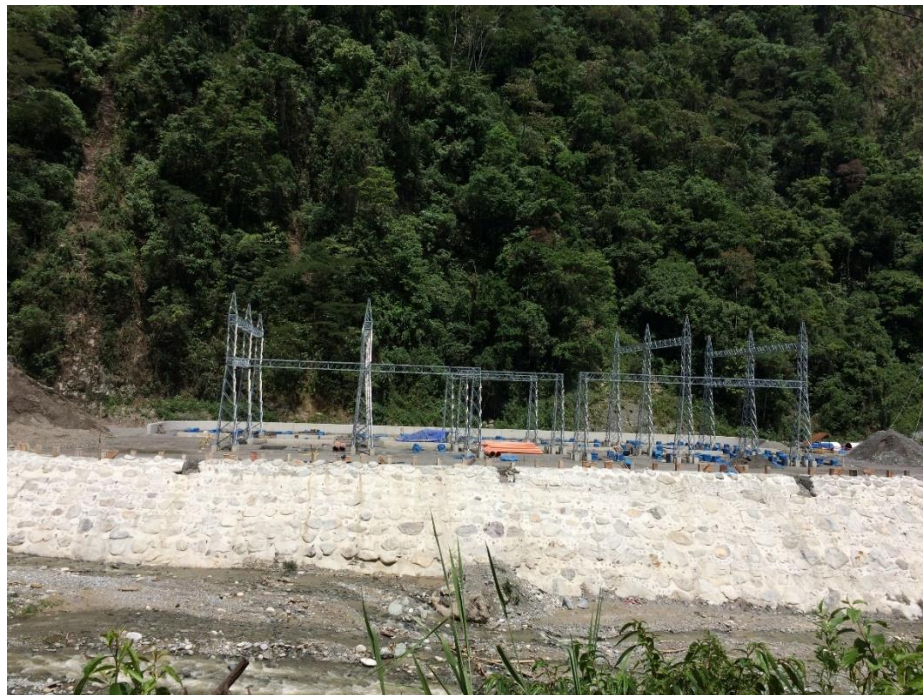
Imagen N° 22 Protección de la rivera del río con muro de contención, localidad Anexo de San José de Utcuyacu, Distrito de Palca, Provincia de Tarma.
