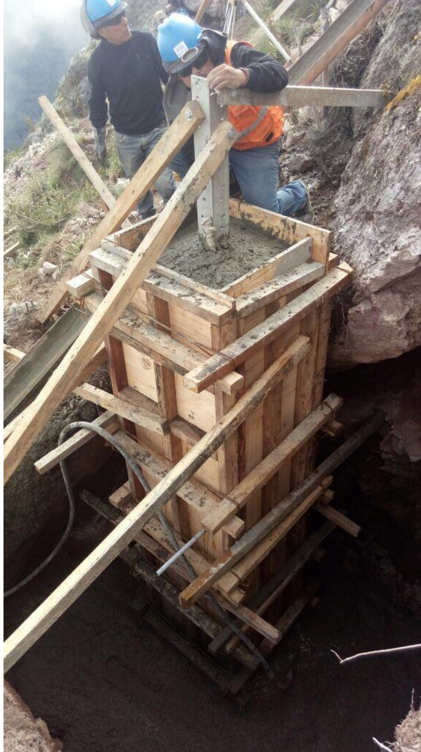
Imagen N° 40 ensamblaje de estructura, localidad C.C. Acobamba, Distrito de Acobamba Provincia de Tarma
