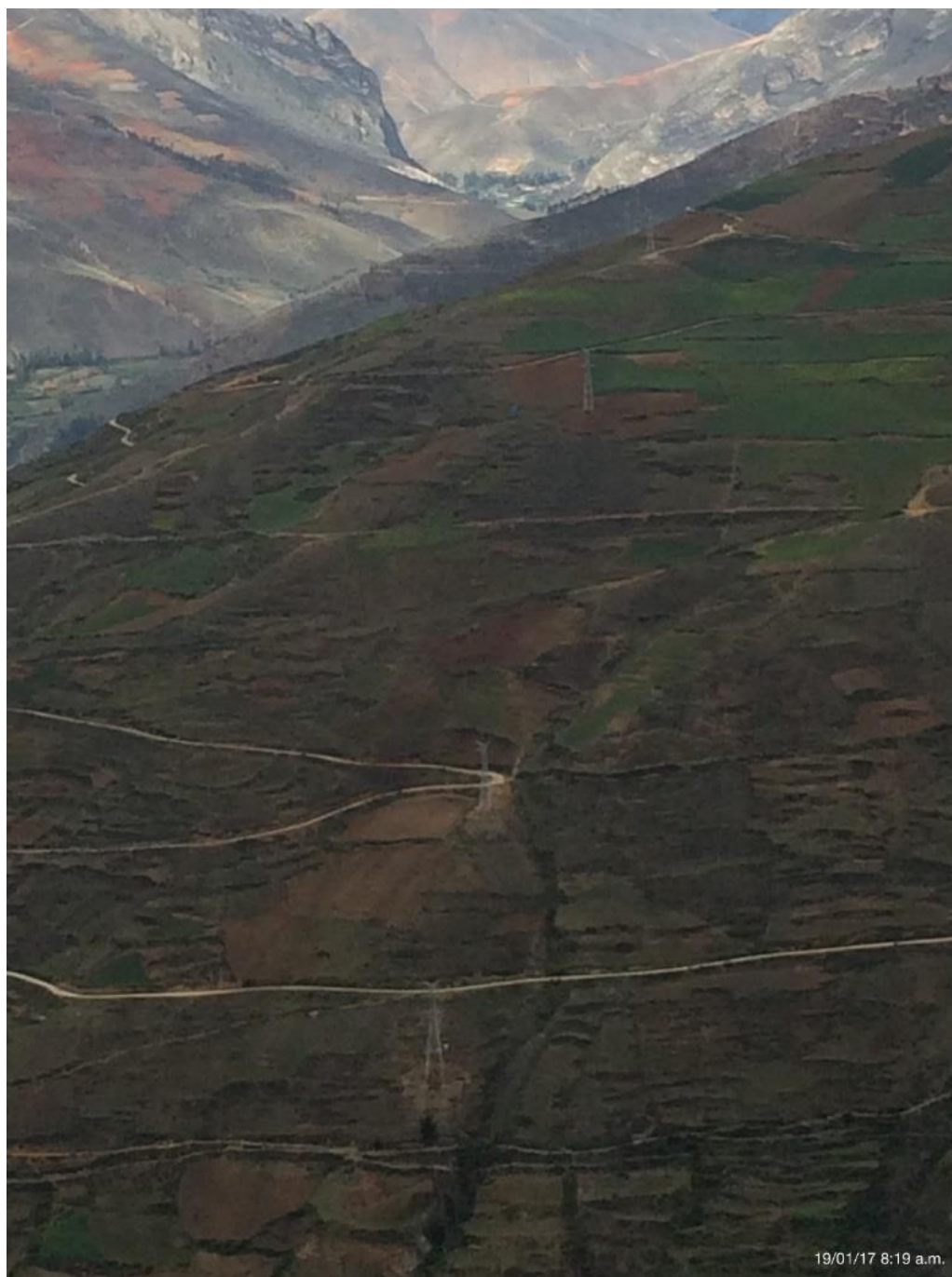
Imagen N° 41 Línea de transmisión, localidad C.C. Palca, Distrito de Palca Provincia de Tarma
