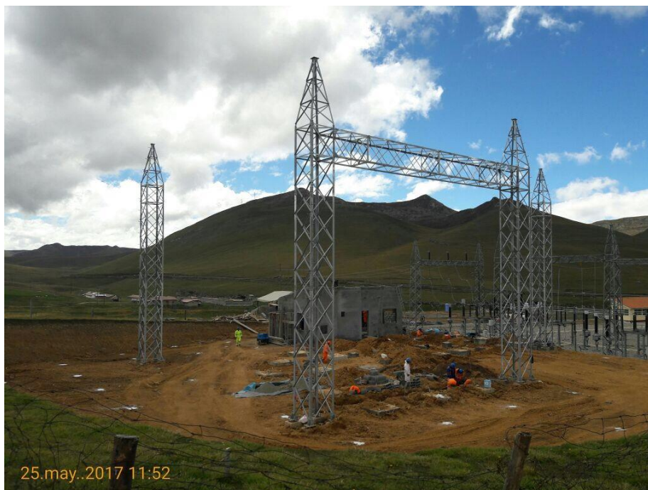
Imagen N° 29 Uso de suelo para ubicación de Sub Estación Caripa, localidad SAIS Tupac Amaru, Provincia de Junín.
