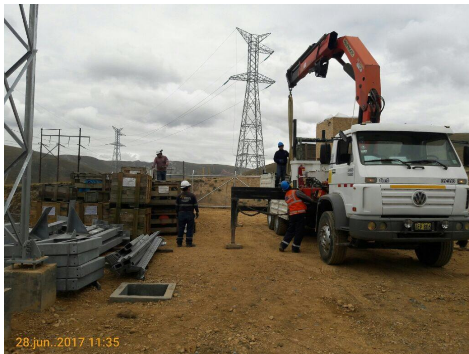
Imagen N° 18 Trabajos de construcción de la Sub Estación Caripa, localidad perteneciente a la SAIS Tupac Amaru, Distrito de Palca, Provincia de Tarma.
