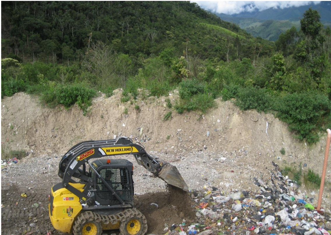
Rellenando con material para tapar los residuos sólidos
