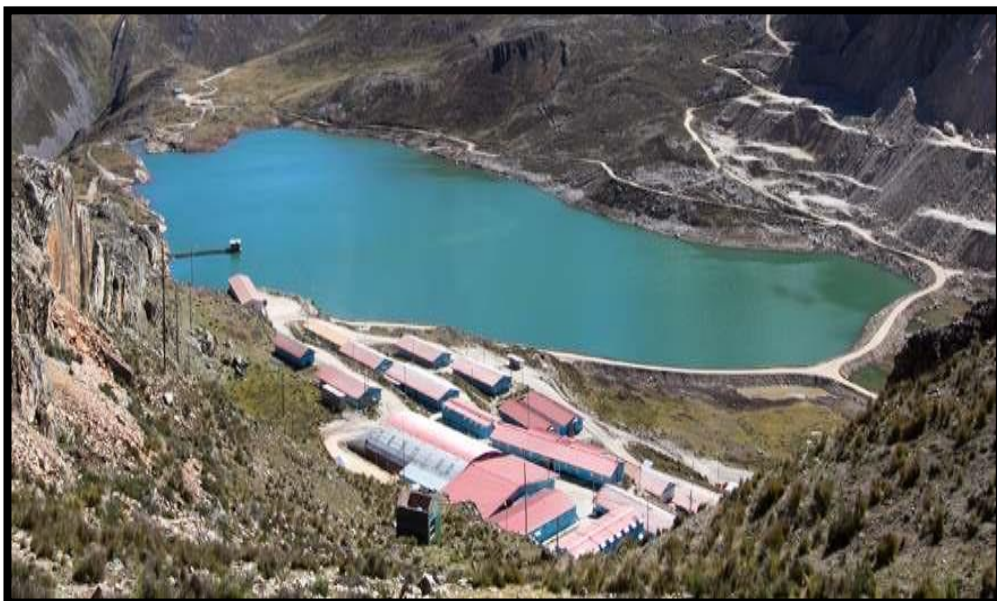
Figura N° 2.1: Vista panorámica de la planta concentradora
