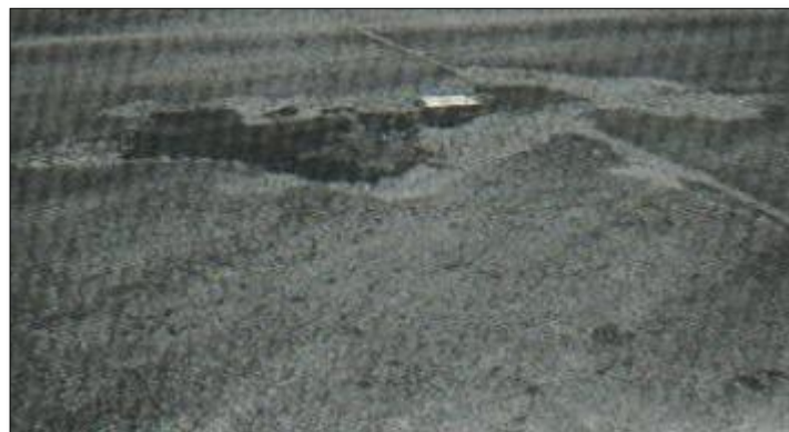
Imagen 49. Desconchamiento / Mapa de grietas / Craquelado de alta severidad.
