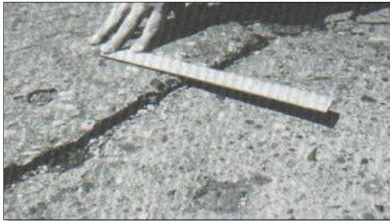
Imagen 21. Escala de severidad media.
