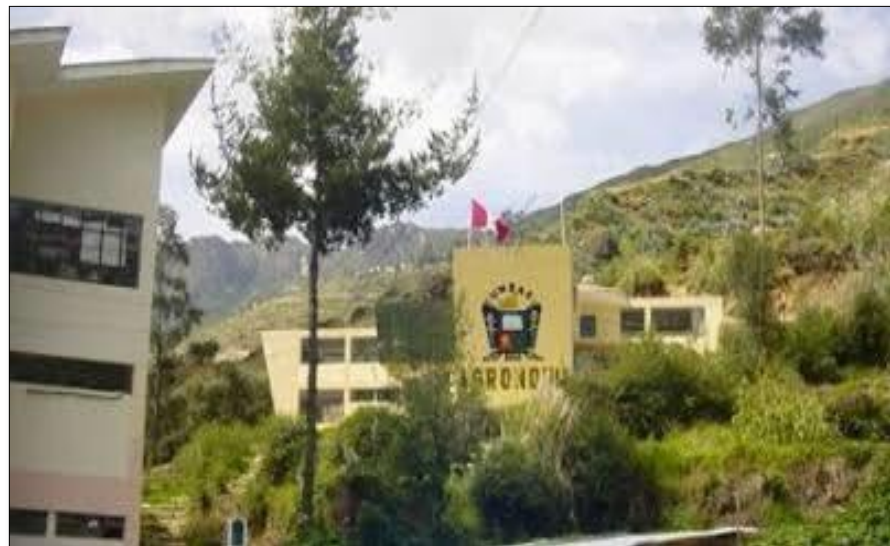
Ilustración 3. UNDAC – Yanahuanca. Fuente: Propio.
