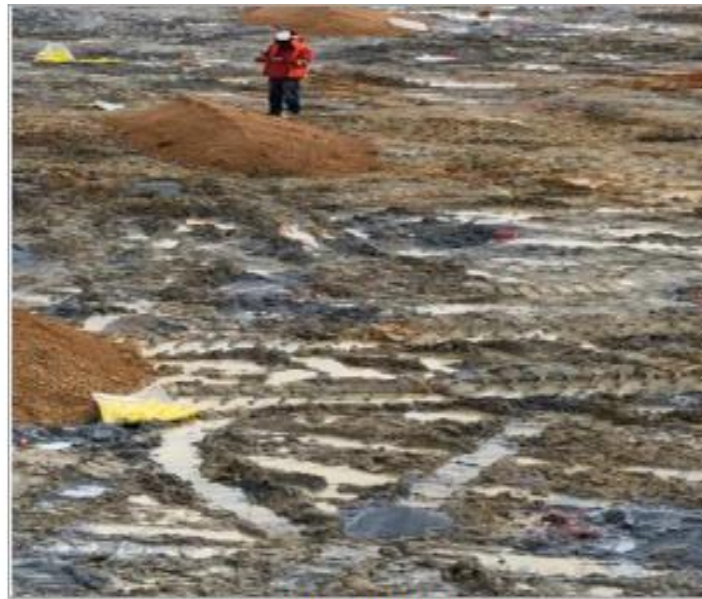
MALLA REPLETA DE AGUA
