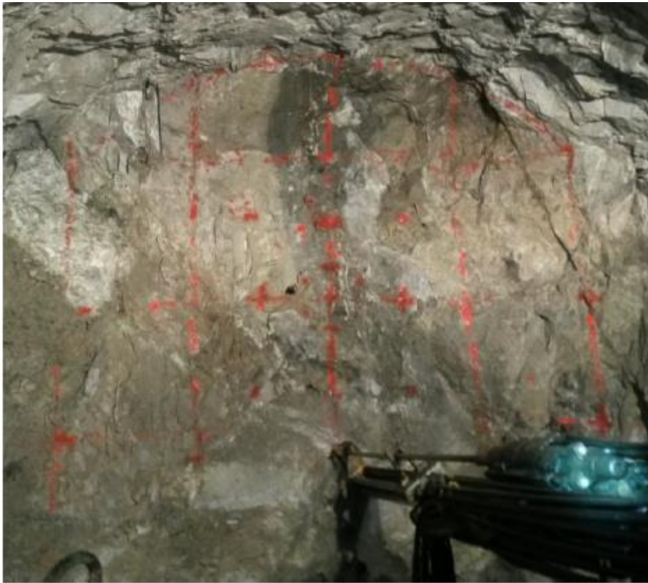
Figura N° 27. Pintado de la malla de perforación sección 3.5 x 3.5 m.
