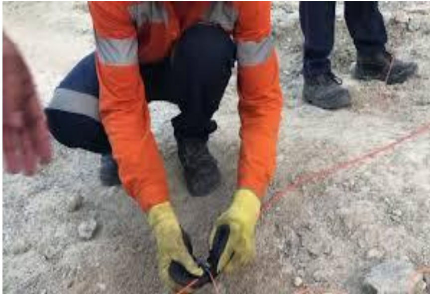
Figura 33. Instalación del sistema silencioso. Fuente: Planeamiento de mina. SMEB.
