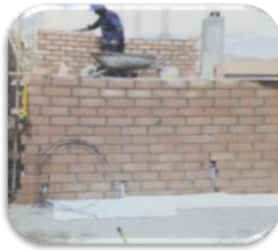
Ilustración 7 Construcción de muros y tabiquería
