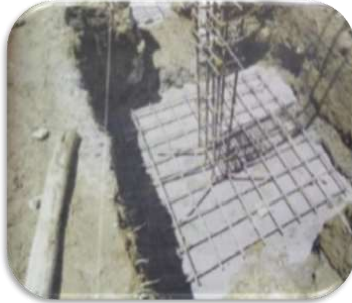
Ilustración 4 Colocación de acero en zapatas
