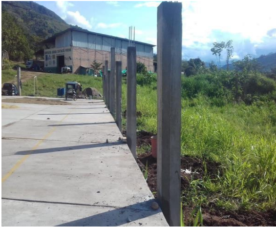
FOTO 1: Armado de columnas
