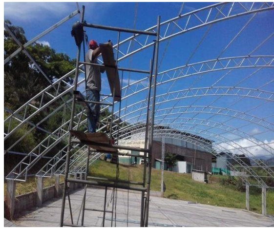
FOTO 2: Construcción del techo
