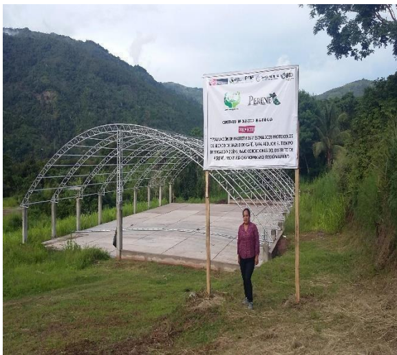
FOTO 3: culminación de la infraestructura
