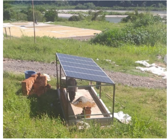
FOTO 6: Instalación de los paneles solares
