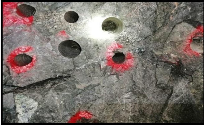
Figura N° 15: Corte en el frente del XC 9109-NE.
