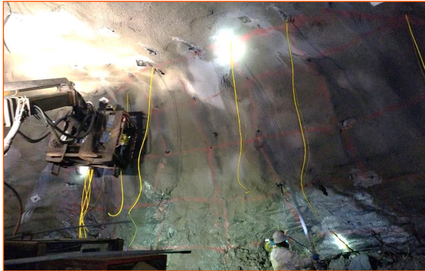
Figura 9: Proceso de perforación de rocas con el equipo ANFOLOADER en la Unidad Minera Nexa Atacocha
