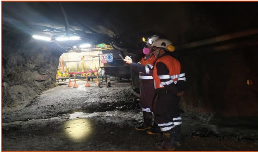
Fotografía 3: Identificación de condición de riesgo, tubería de 2” HDPE asegurada con sogas, con riesgo de soltarse y caer del techo – Entrada de la estación de bombeo del Nv. 3060
