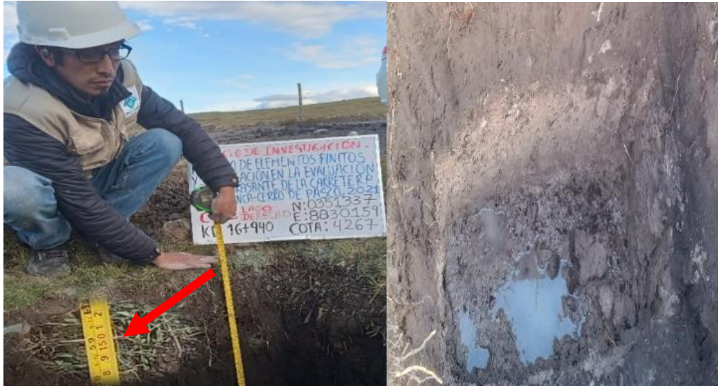
Excavación manual de la Calicata 02 a 1.50 metros de profundidad.
