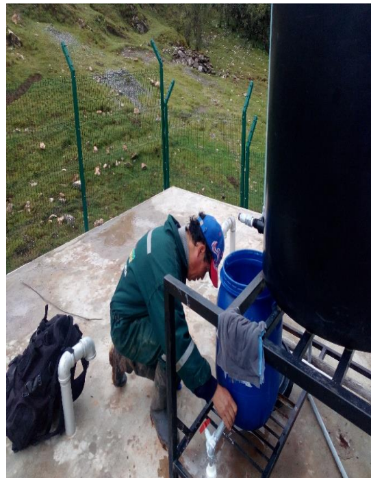
Foto 08: Tesista realizando el mantenimiento y lavado del tanque dosificador de solución madre del sistema de cloración para optimizar el proceso de desinfección del agua en el reservorio – “Chinhuayhuay”.
