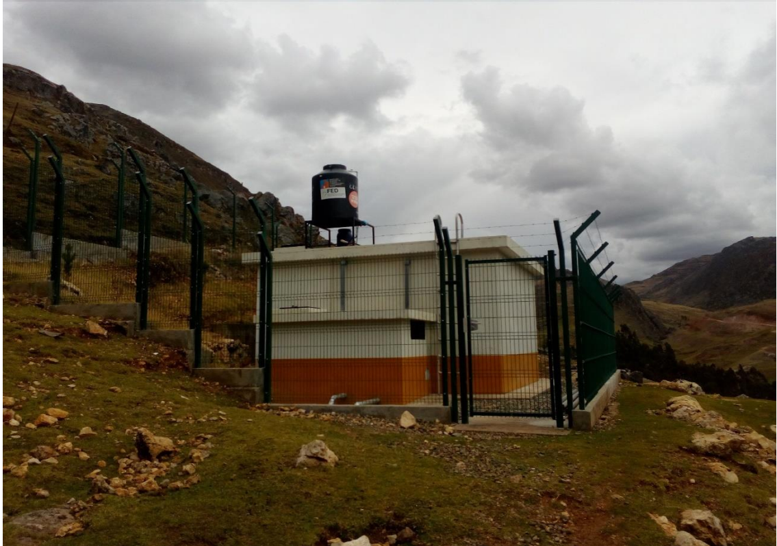
Foto 13: Vista frontal del reservorio y sistema de cloración por goteo convencional del sistema de abastecimiento de agua – “Torohuaganga”.
