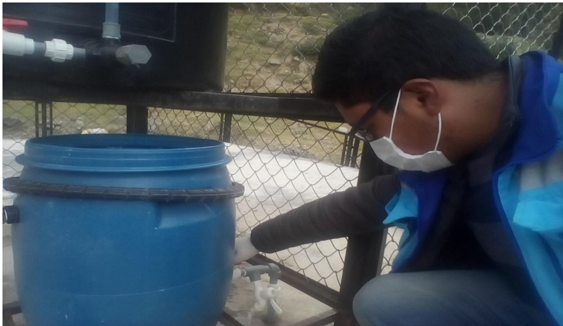
Foto 06: Tesista realizando la evaluación técnica, toma de datos y georreferenciación de la captación del sistema de abastecimiento de agua “Chinuanhuay” – Ticlacayán.
