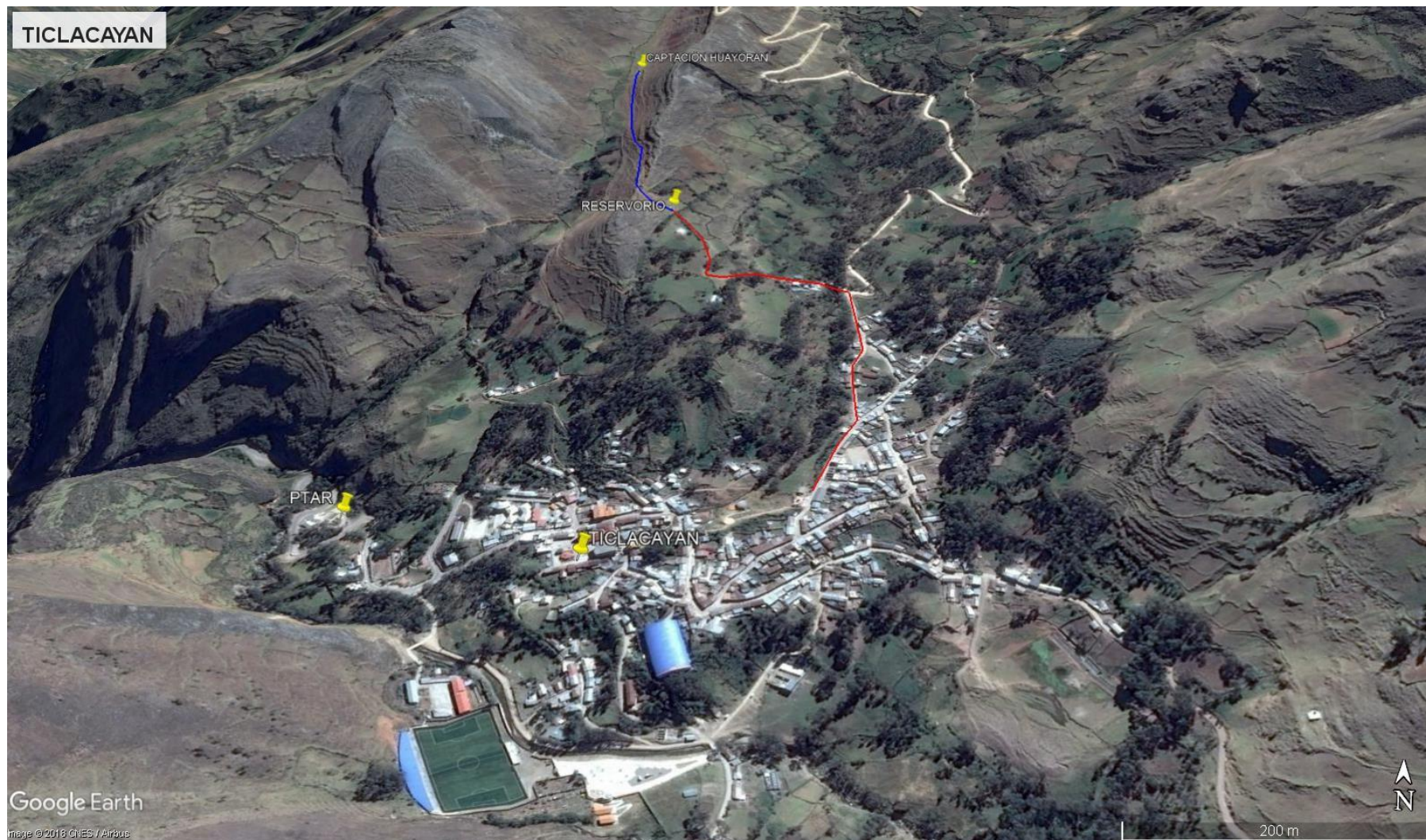
Imagen 12: Sistema de abastecimiento de agua – SAP Huayruran.
