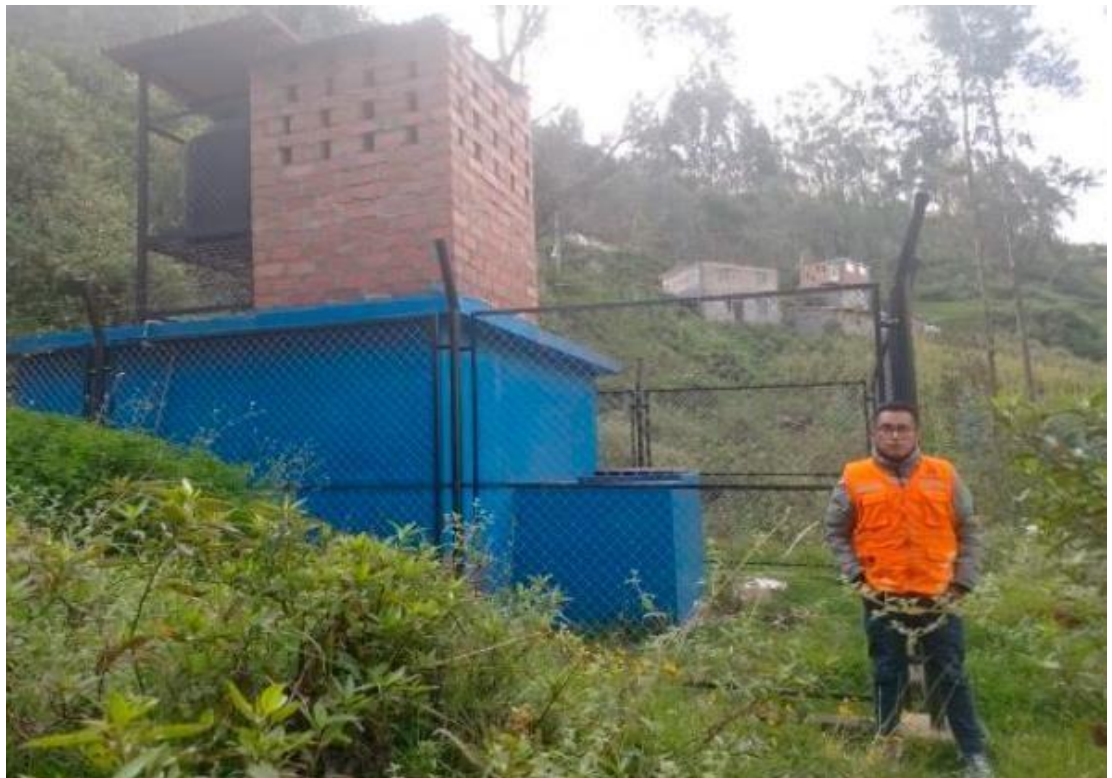
Fig. 7 Reservorio de Batanchaca y sistema de cloración por goteo
