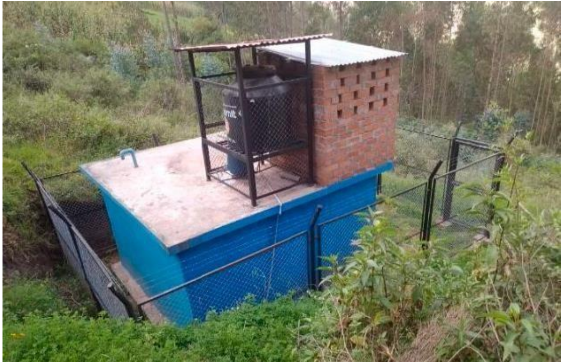
Fig. 7 Reservorio de Batanchaca y sistema de cloración por goteo
