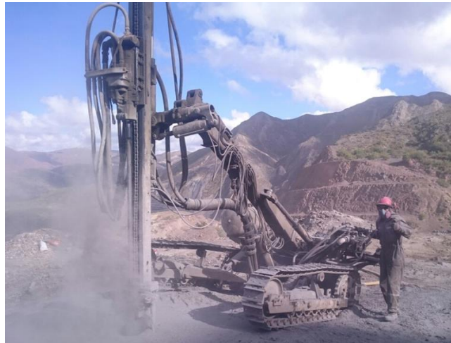
Equipo de perforación Track Drill
