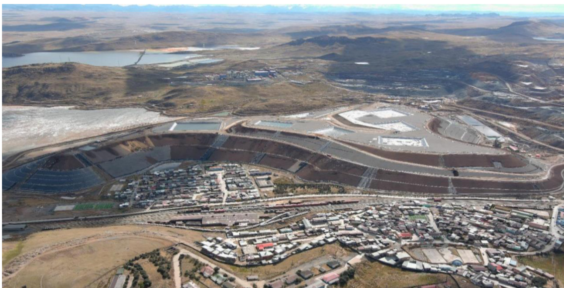
figura 42. Trabajos realizados a nivel de geosintéticos
