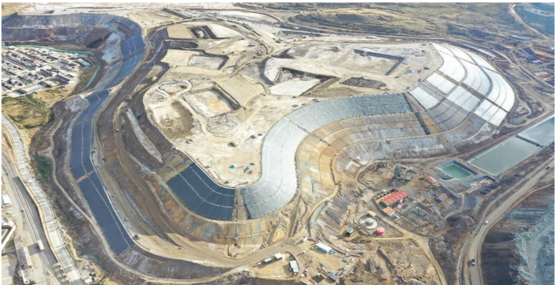
figura 35. Geosintéticos Instalados
