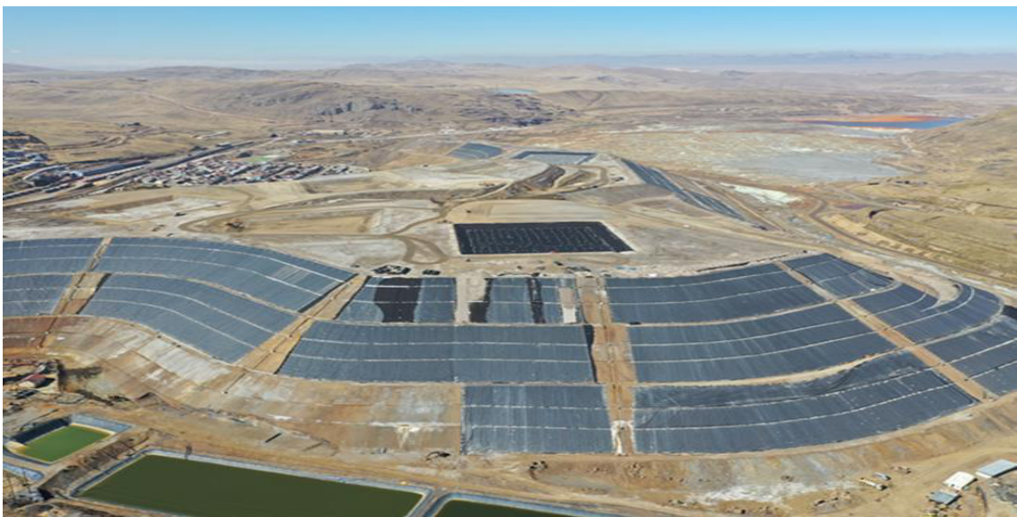
figura 37. Geosintéticos instalados
