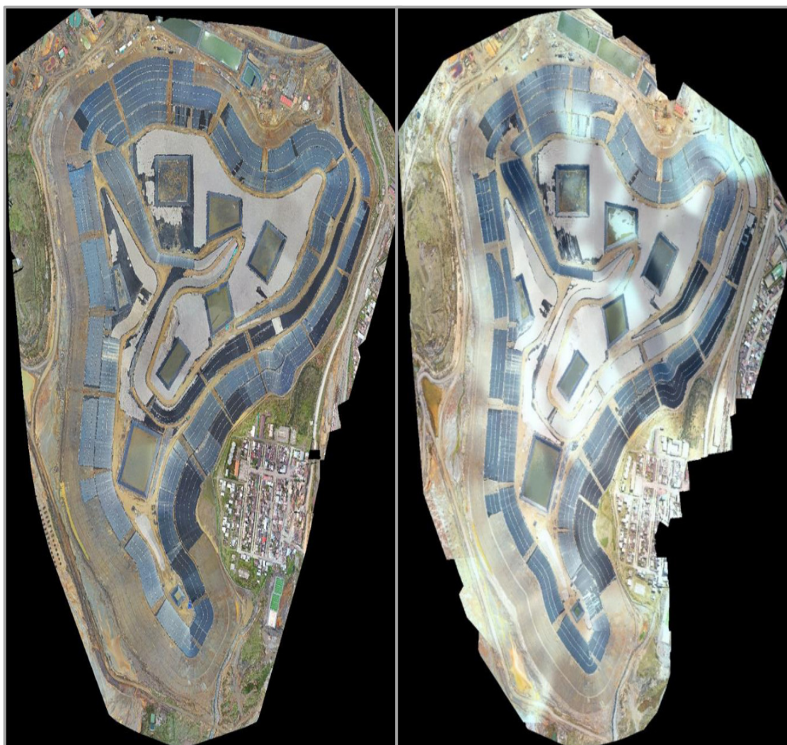
figura 26. Ortofoto de la desmontera Excélsior
