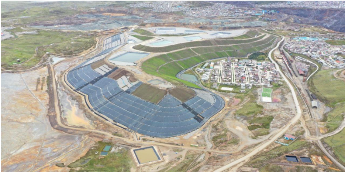
figura 44. Geosintéticos a nivel de la capa 1 y 2 concluido
