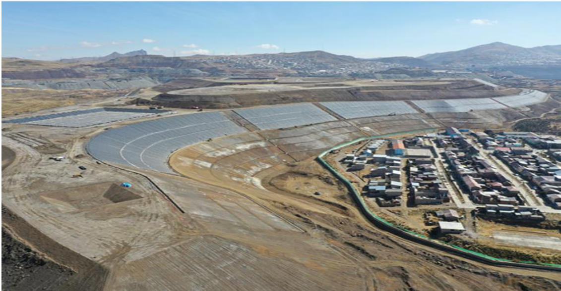
figura 36. Perfilado de talud e inst. geosintéticos
