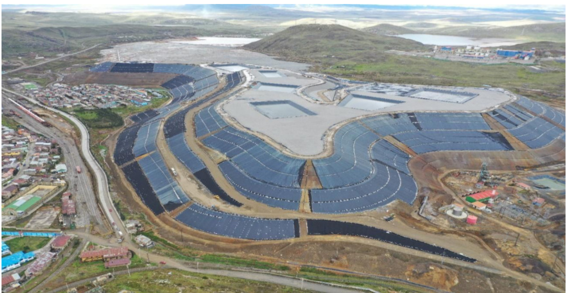
figura 39. Geosintéticos y piedra canto rodado en plataforma
