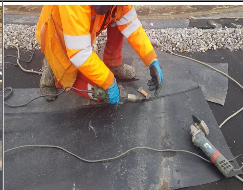
FOTO N° 16 INSTALACIÓN DE GEOMEMBRANA EN TALUD SOLDADURA POR EXTRUSIÓN
