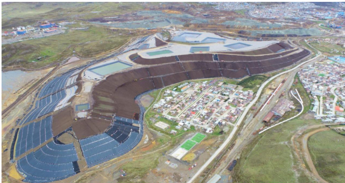
figura 43. Trabajos de coberturas de avance más del cincuenta por ciento
