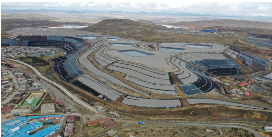
figura 41. Desmontera Excelsior durante la paralización Covid-19
