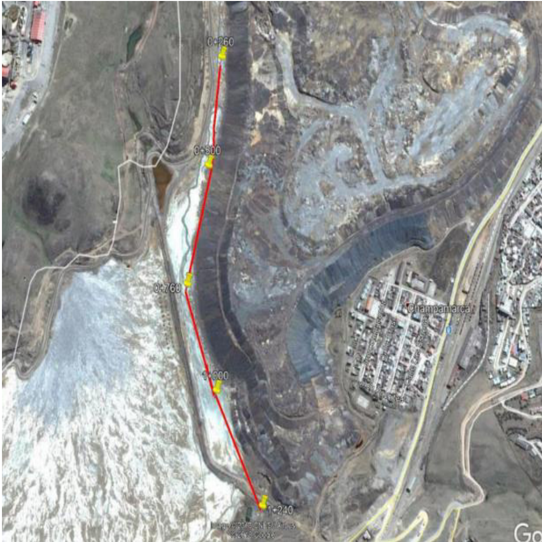
figura 11. Tramo de mejoramiento de pie de talud
