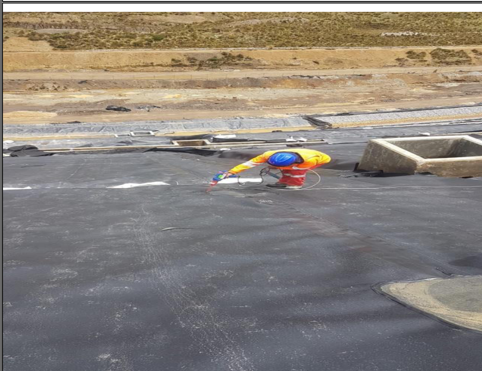
FOTO N° 15 INSTALACIÓN DE GEOMEMBRANA EN TALUD SOLDADURA POR EXTRUSIÓN
