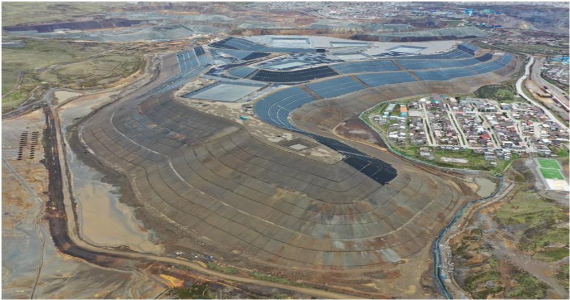
figura 38. Instalación de geosintéticos
