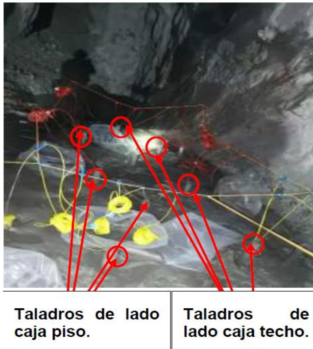
Figura 25. Taladros de caja piso y de caja techo
