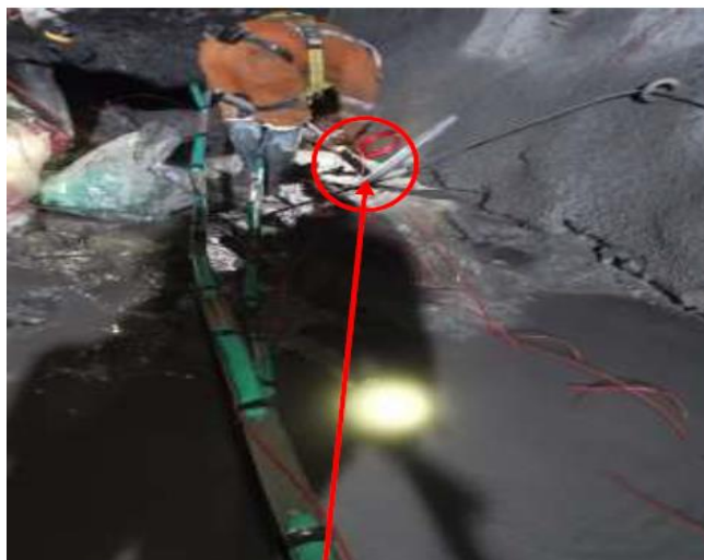
Figura 24. Carguío de taladros de la caja techo
