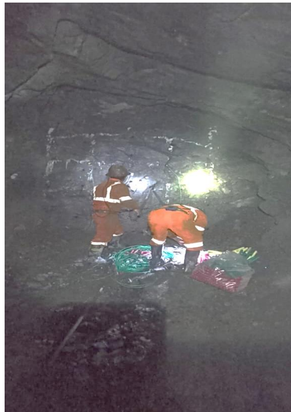
Figura 32: Carguío de explosivos
