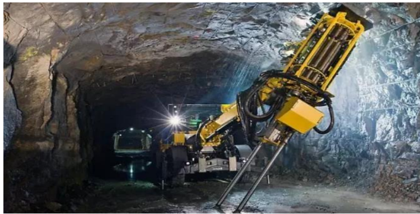
Figura 5: Perforación con Jumbo
