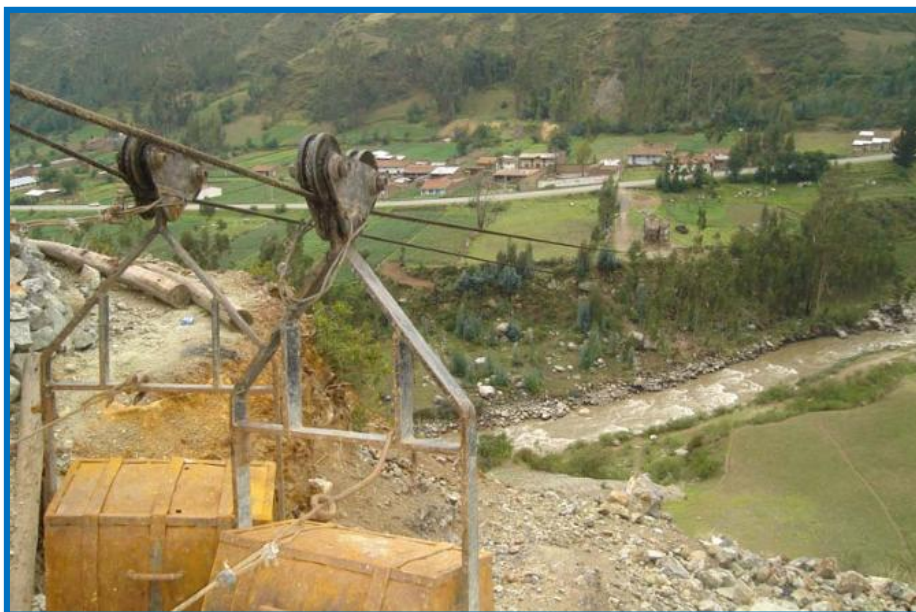
Foto N° 2: Punto de Carguío de Mineral y Cable Carril de la Operación Actual
