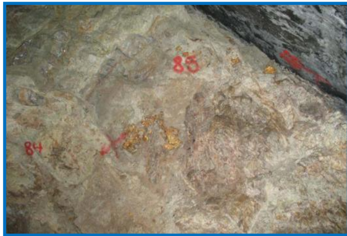
Foto N° 6: Cortada Nivel 3220 se observa Falla en Contacto
