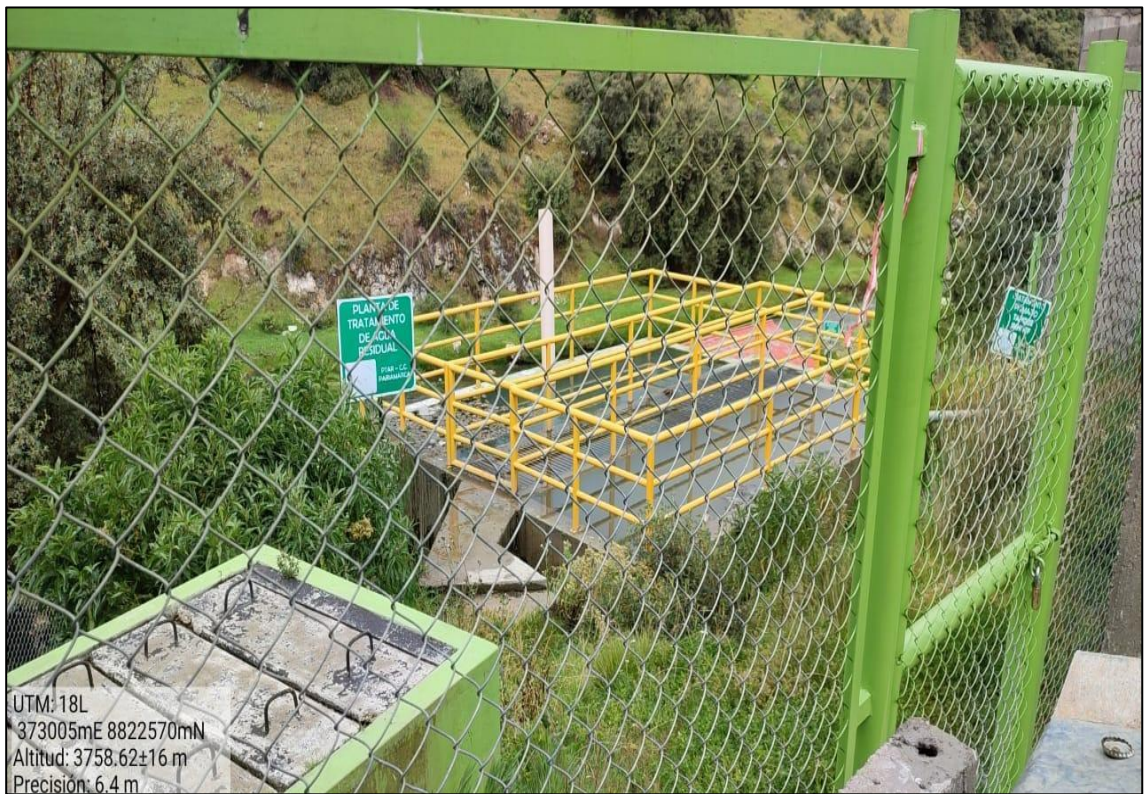
Fotografía 2: Ubicación de la Planta de Tratamiento de Aguas Residuales (cámara de rejas y tanque imhoff)
