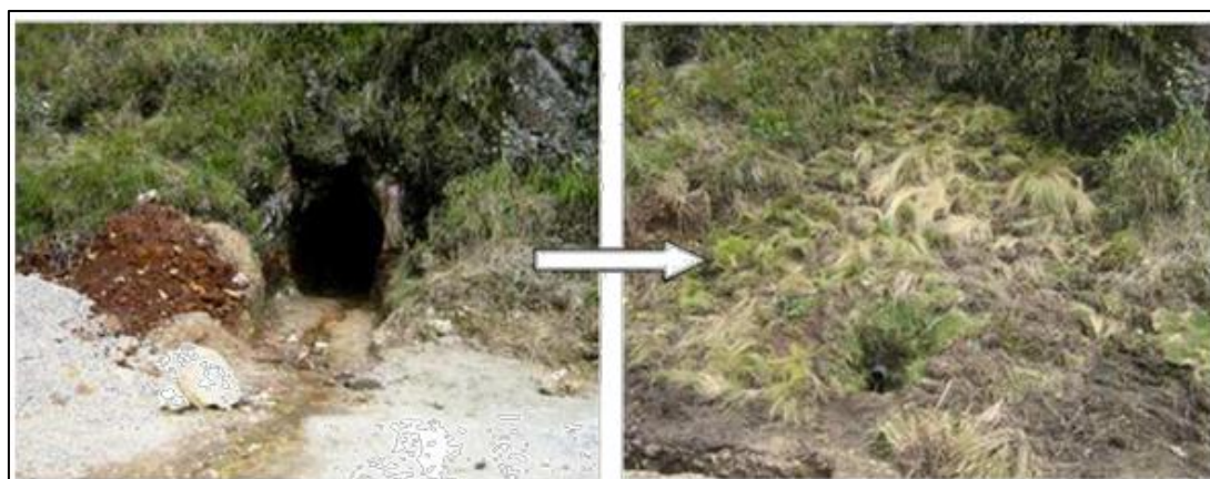
Ilustración 19. Bocamina antes y después de ser rellenada y revegetada
