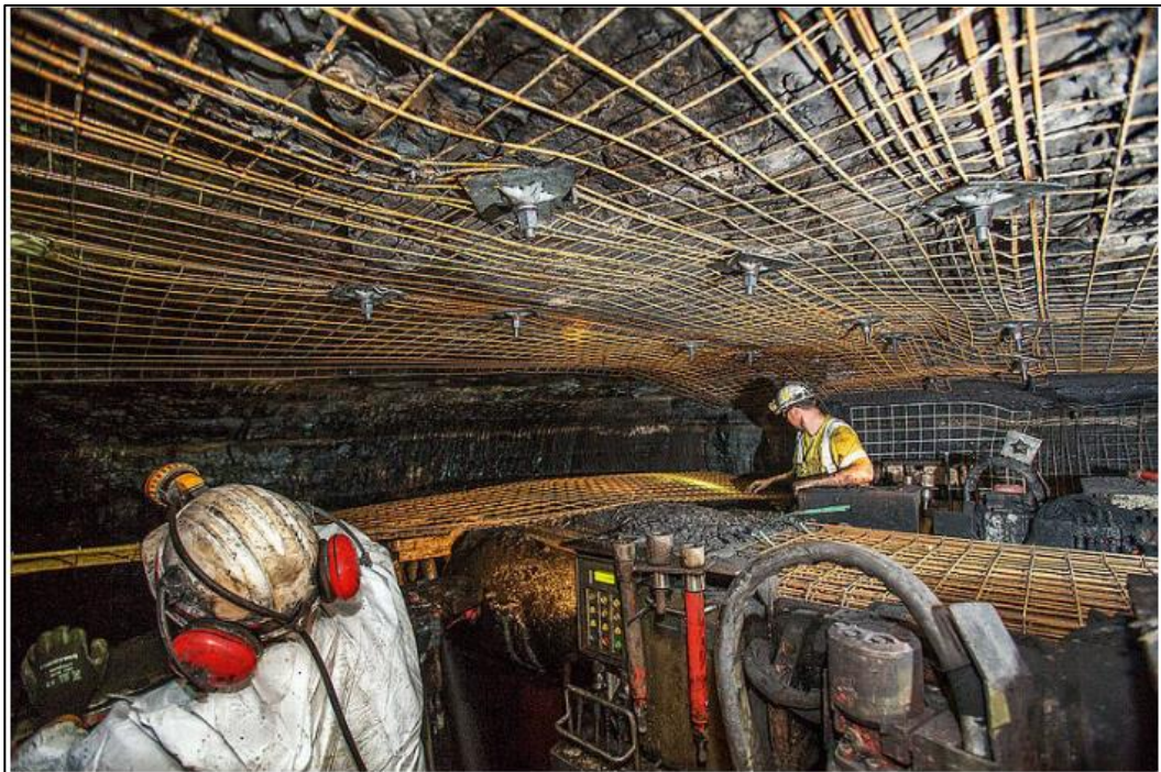
Ilustración 16. Instalación Manual de malla electrosoldada
