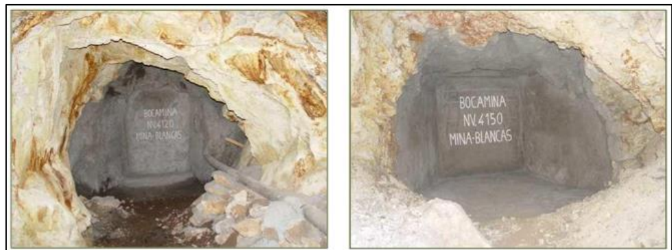
Ilustración 18. Cierre de bocamina con drenaje y sin drenaje
