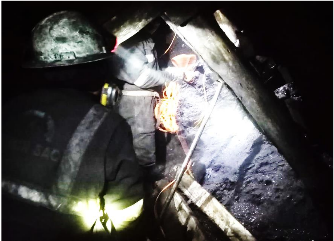
Preparando la carga para el disparo, Unidad Minera Palmahuay
