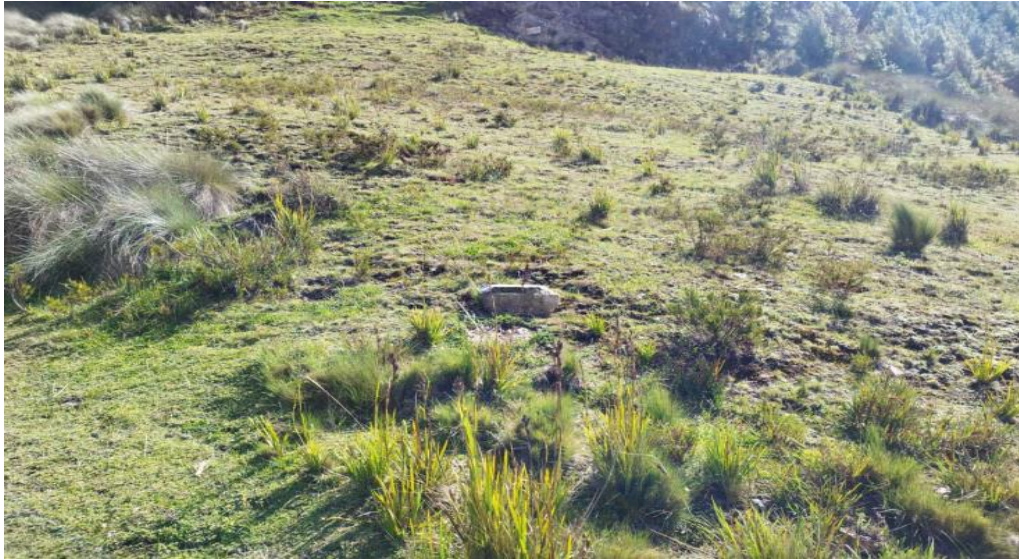
IMAGEN 4.5.. Vista de cierre de bocaminas (B4-43) presenta estabilidad física.
