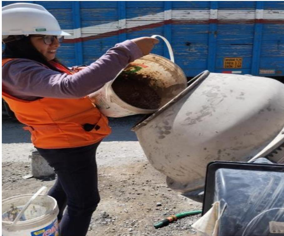
**Fotografía 05.** Proceso adición de los agregados para el diseño de mezcla.
