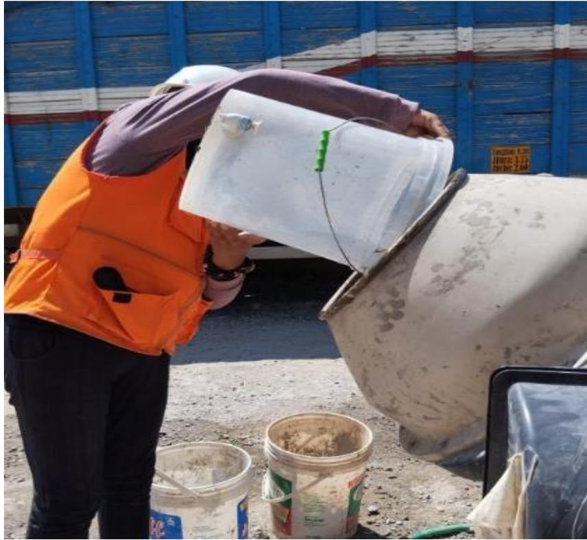
**Fotografía 06.** Proceso adición de agua para el diseño de mezcla.
