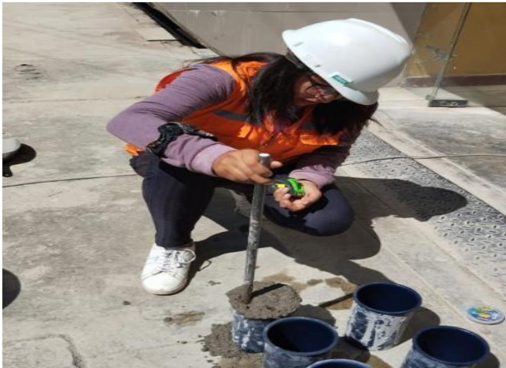
**Fotografía 16.** Proceso del chuceado para homogenizar el concreto en las probetas.
