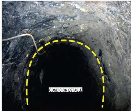
La forma em arco de las excavaciones favorece la estabilidad
