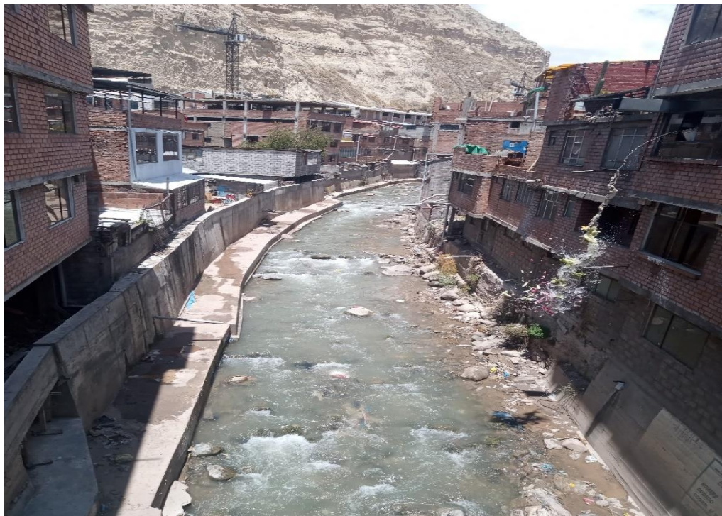
Imagen 3. Vista del vertimiento de agua residual y residuos al río Yauli
