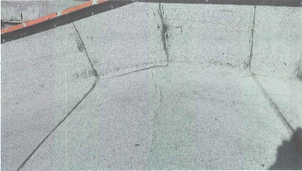
Colocación del manto con gavillado
