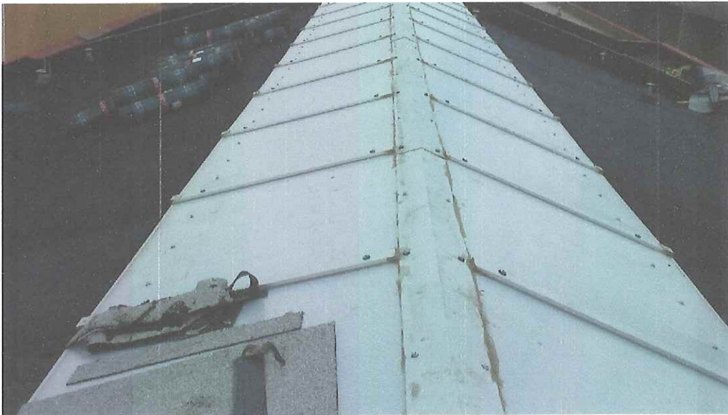
Colocación de impermeabilizante
