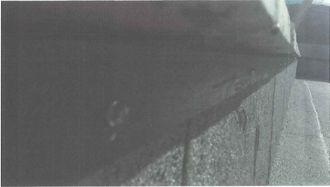
Fijación del manto asfáltico gavillado
