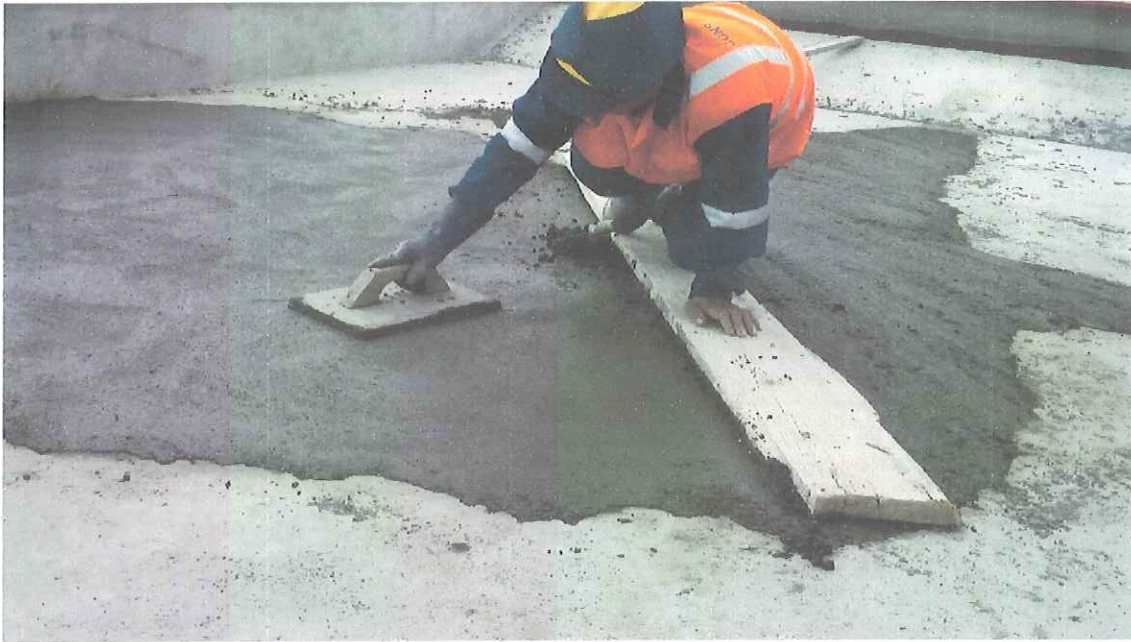
Preparación de techos parara impermeabilización
