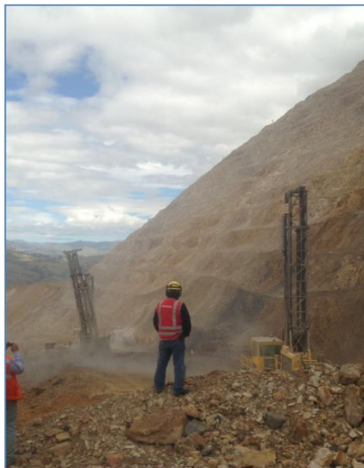
Figura 50 Se observa que la perforadora del lado izquierdo perfora en ángulo a diferencia de la perforadora en el lado derecho
