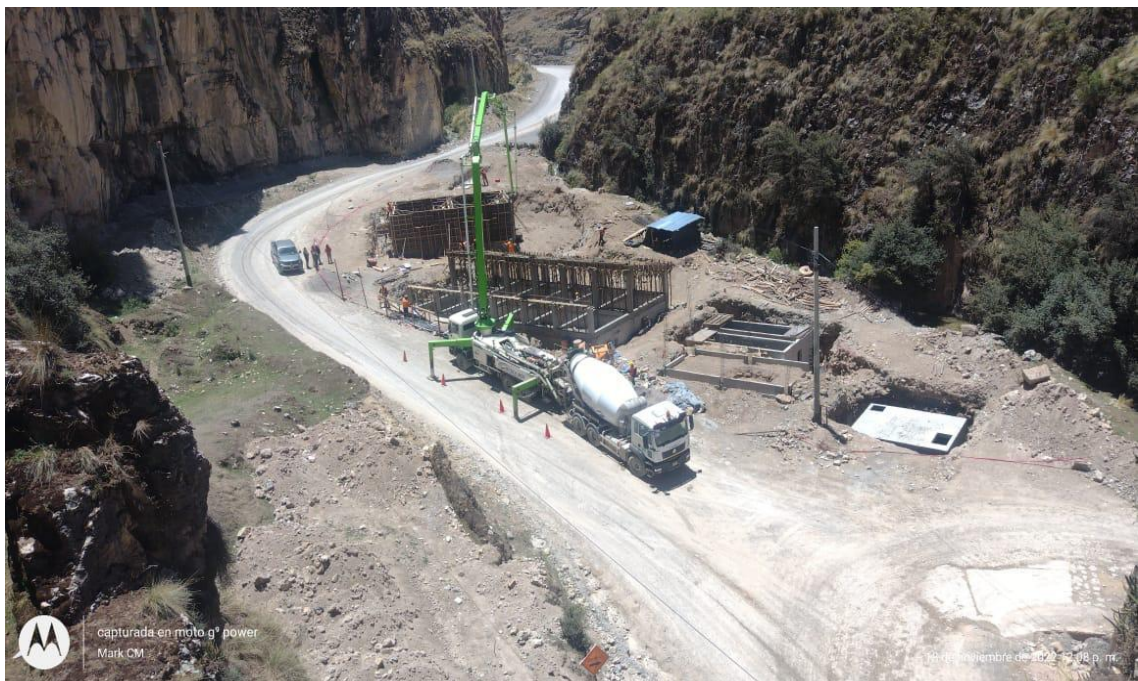
Fotografía 5: colocación de concreto impermeabilizante en estructuras hidráulicas
