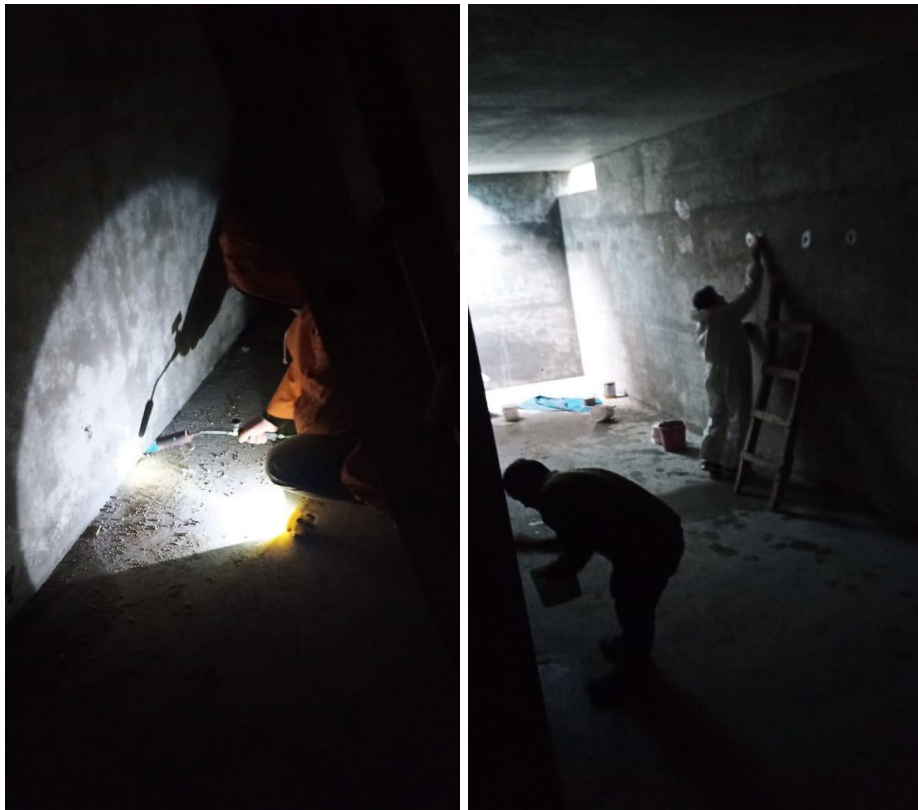
Fotografía 7 y 8: Verificación de estructuras de concreto y colocación de morteros en estructuras hidráulicas
