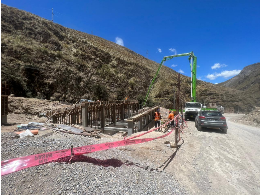
Fotografía 6: colocación de concreto impermeabilizante en estructuras hidráulicas
