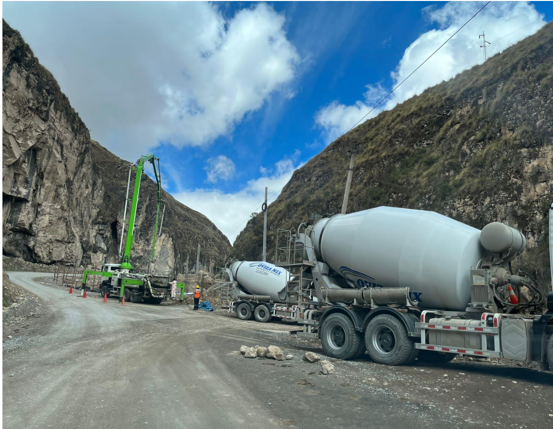
Fotografía 4: colocación de concreto impermeabilizante en estructuras hidráulicas
