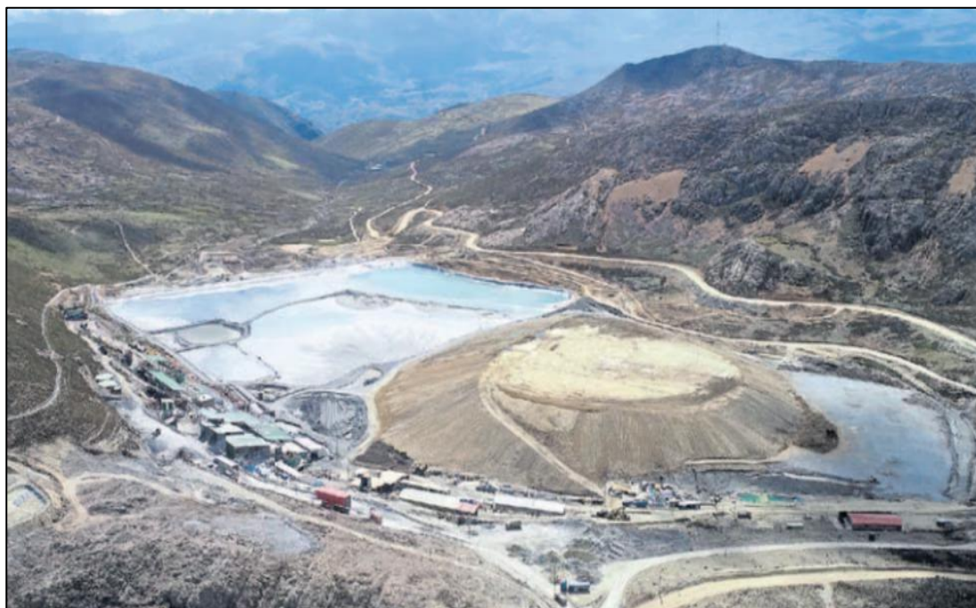
Ilustración 2. Vista Panorámica de la Compañía Minera Lincuna S.A.
