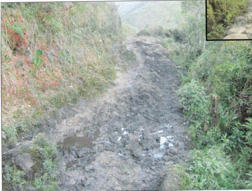
**PRESENCIA DE AGUA DEL SUB SUELO PRODUCE FILTRACIÓN Y PEQUEÑOS DESLIZAMIENTOS EN EL TALUD ADYACENTE EN EL TRAZO DE LA CARRETERA.**
