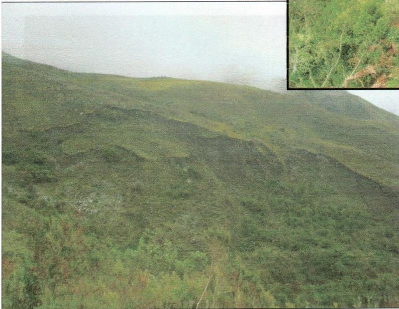
**PRESENCIA DE DERRUMBES Y/O DESLIZAMIENTOS EN EL TALUD DEL TRAZO DE LA CARRETERA, NÓTESE EL SALTO EN LA CABECERA.**
