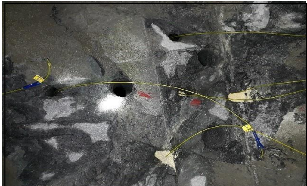
Ilustración 11. Frente cargado y amarrado.
