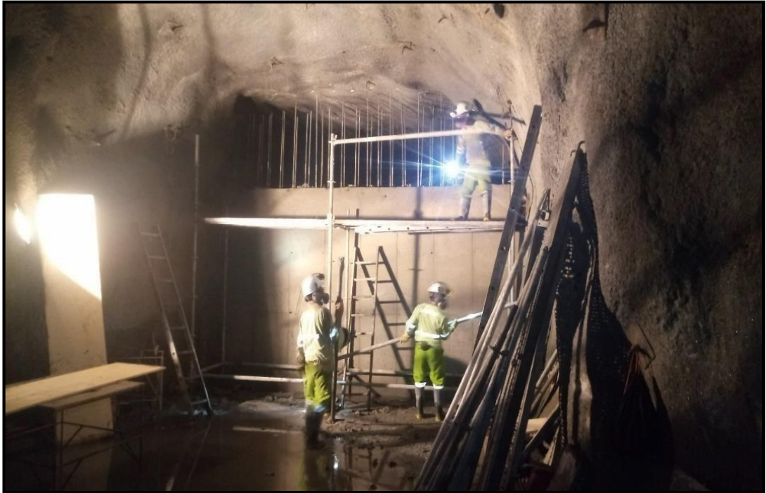
Ilustración 22. Estructurado 1er nivel de un muro tapón de concreto.
