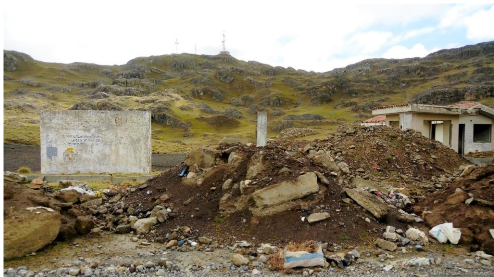
Figura 42. Zona 2 de la Ruta 7 Ingreso a Relleno Sanitario Abandonado y Desmantelado.
