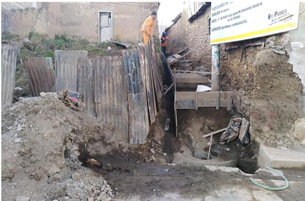
Figura 53. Encofrado de las Graderías y Veredas.
