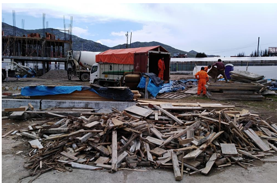
Figura 61. Maderas luego de su Uso como Encofrados en Obra.
