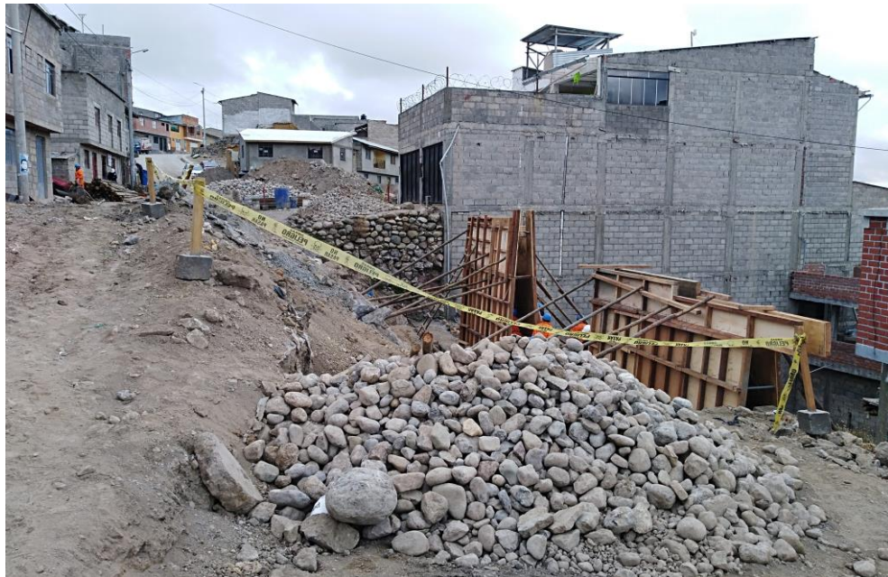
Figura 57. Encofrados de los Muros de Contención y Agregados.
