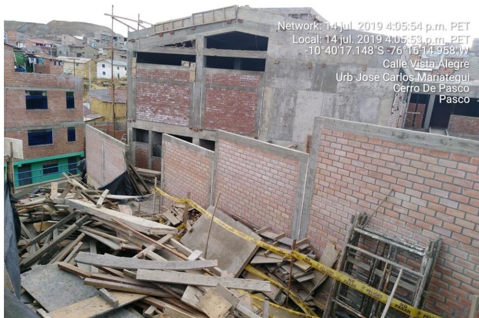
Figura 55. Maderas y Paneles Mal Almacenados, para Encofrados de obra.
