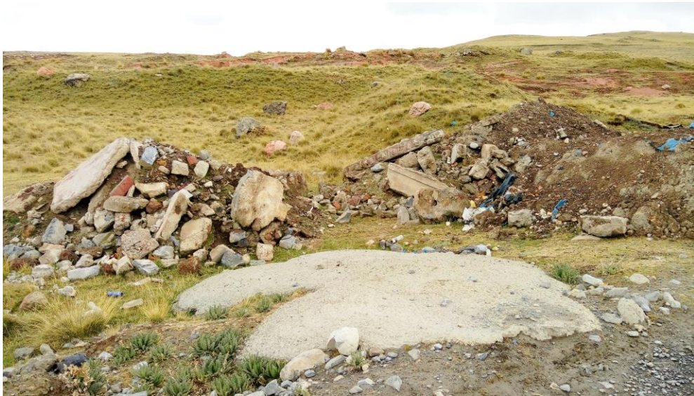
Figura 45. Zona 4 de la Ruta 7 Restos de Concreto Premezclado.
