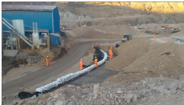
Foto N° 10.- Conformación del refuerzo de taludes, progresiva 0+490 a 0+573, zona angosta por la por la colindancia de la vía nacional y el laboratorio químico; el inicio del despliegue de geomalla uniaxial tejido de dió en la cota 4614 msnm.
