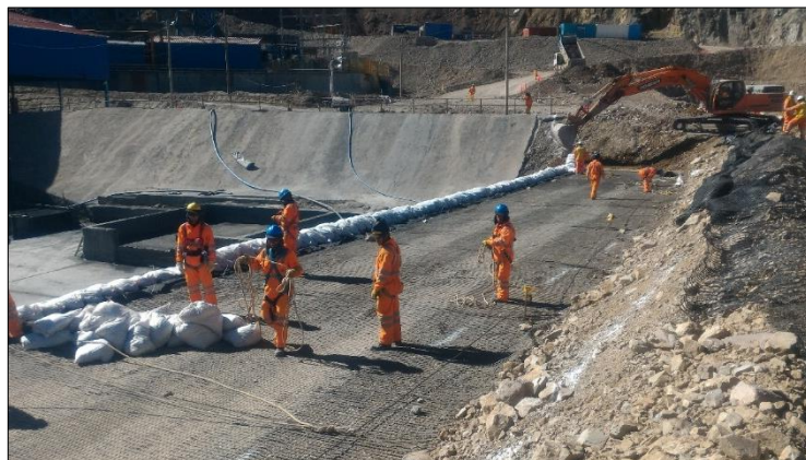
Foto N° 06.- Trabajos de despliegue de geomalla uniaxial y el encostalado de material GC-GP, para ser colocados en el extremo de la plataforma (vía nacional) con el propósito inicial, de retener el material cuando esta es colocado.
