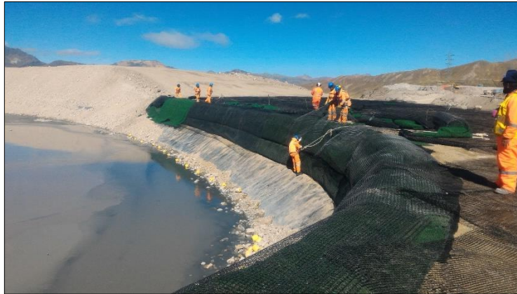
Foto N° 11.- Vista de los trabajos de conformación del refuerzo de talud (0.4H:1V) agua bajo con el uso de geosintéticos conjuntamente geomalla uniaxial para el refuerzo del cuerpo de presa. El muro aguas abajo tendrá una elevación de 11 m.
