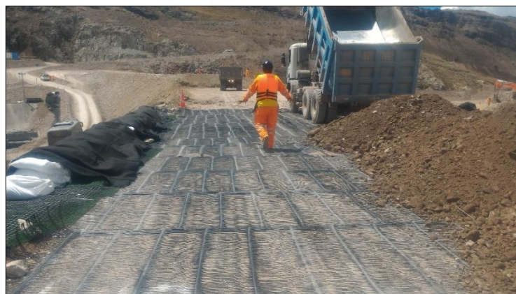
Foto N°14.- Vista de la geomalla uniaxial HDPE desplegada para el último refuerzo de cuerpo de presa, que va de la progresiva: 0+490 a 0+520.
