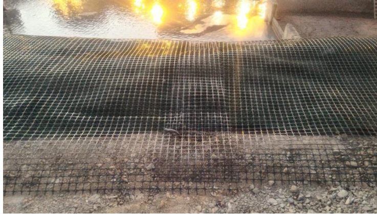
Foto N° 07. - Vista de la verificación de longitud de empotramiento 1.20 m (geomalla biaxial) para el refuerzo de talud, que va de la progresiva 0+575 a 0+612, se traslaparon 15 cm por panel como buena práctica. La geomalla biaxial conjuntamente con el geomanto envuelven 03 capas (1.20 m) compactadas cada una de estas capas esta reforzada con geotextil no tejido.
