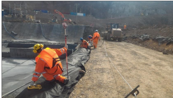
Foto N° 05.- Vista de los trabajos de control topográfico permanente en la conformación de refuerzo de talud usando geosinteticos (geotextil, geomanto y geomalla biaxial) con una inclinación de 0.4H:1V.
