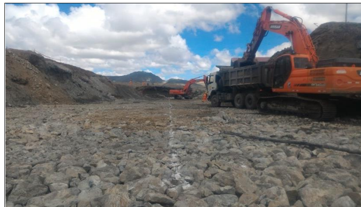
Foto N° 02.- Vista el enrocado parte de la cimentación del estribo oeste, que va de la progresiva 0+550 a 0+620 alcanzando la cota 4615.0msnm.
