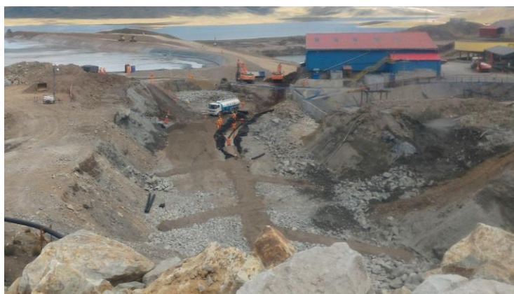
Foto N° 03.- Construcción de un sistema de drenaje (subdren con ramales) nivel del enrocado, de la progresiva 0+560 a 0+660, con una evacuación igual a 1.5%.
