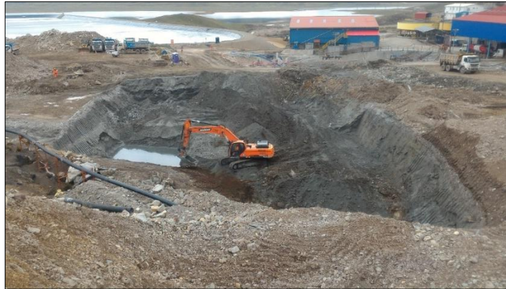
Foto N° 01.- Vista de la Excavación e eliminación del relave existente (relave antiguo) en la zona donde se realizara la cimentación del estribo oeste de la progresiva 0+550 a 0+700, se profundiza hasta conseguir un terreno competente.
