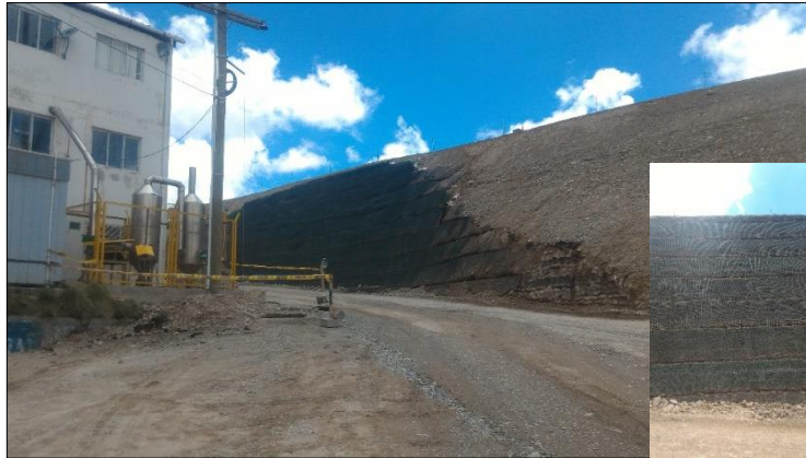
Foto N° 15.- Vista del refuerzo del talud 0.4H:1V aguas abajo del estribo oeste de la presa de relaves Animon, brindando con ello el normal recorrido de la vía nacional y la conservación de la estructura de Laboratorio Químico de Planta concentradora Chungar.
