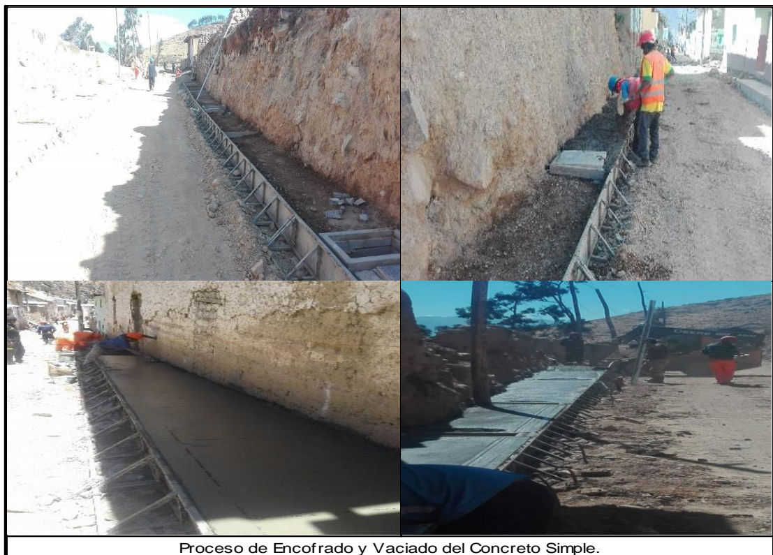
Figura 44: Vista de Trabajos de Veredas de Concreto Simple F'c=175\text{kg/cm}^2 , Programación Tradicional.
