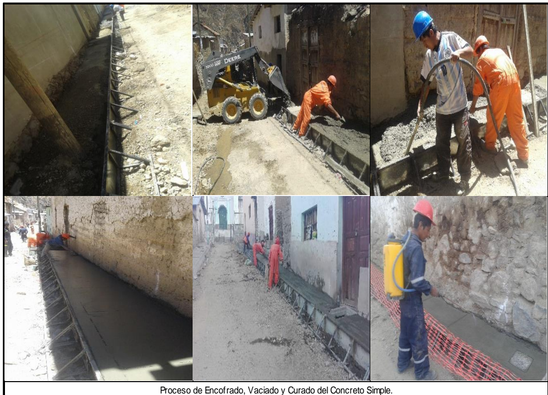
Figura 45: Vista de Trabajos de Veredas de Concreto Simple F'c=175\text{kg/cm}^2 , Programación Lean Construction.
