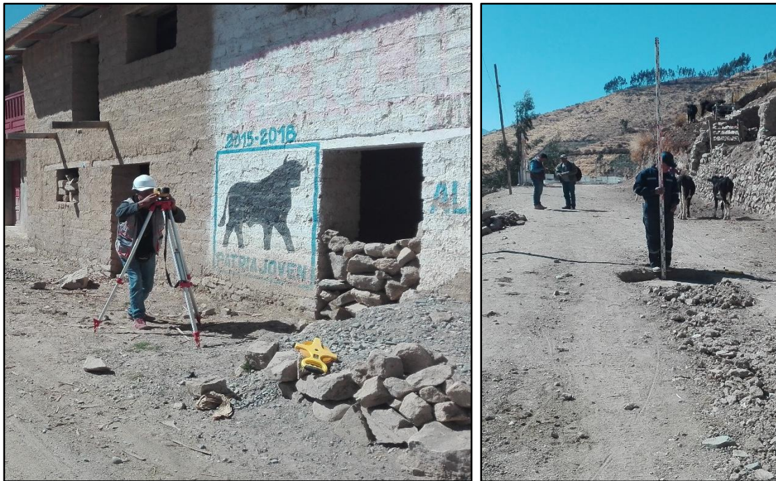
Figura 2M: Trazo, Nivelación y Replanteo del Proyecto.
