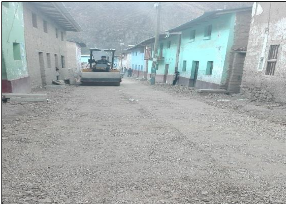
Figura 10M: Compactación con Maquinaria Pesada. (Fuente: BDC Ingeniería & Construcción E.I.R.L.)
