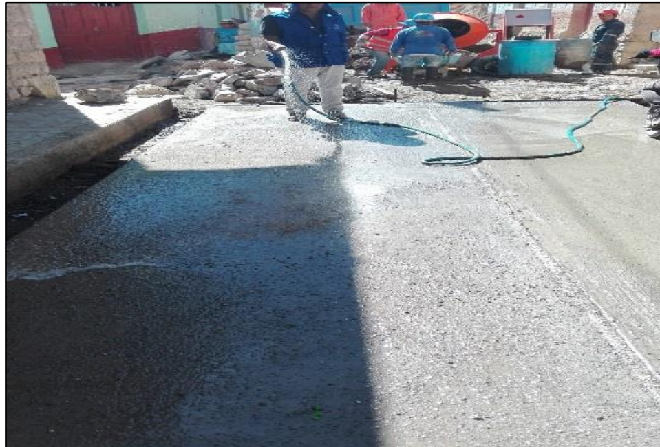
Figura 18M: Curado del Concreto Rígido con Agua. (Tradicional) (Fuente: BDC Ingeniería & Construcción E.I.R.L.)
