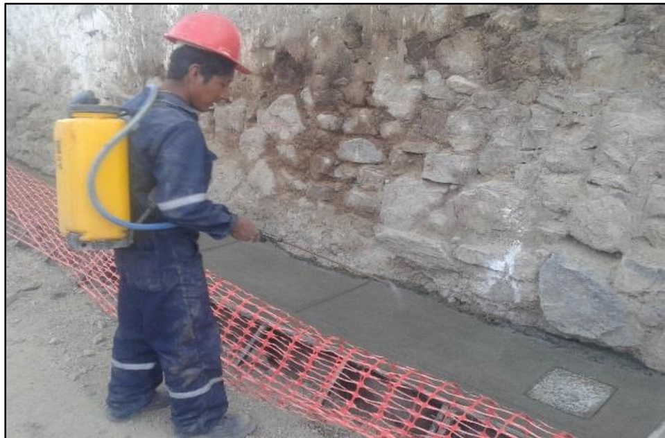
Figura 42M: Curado del Concreto en Veredas. (Lean Construction) (Fuente: BDC Ingeniería & Construcción E.I.R.L.)
