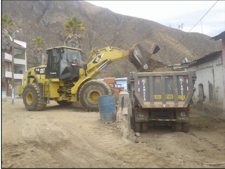
Figura 7M: Eliminación del Material de Corte y Excedente. (Fuente: BDC Ingeniería & Construcción E.I.R.L.)
