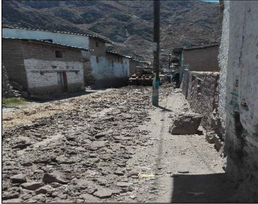
Figura 3M: Escarificado del Terreno con Maquinaria Pesada. (Fuente: BDC Ingeniería & Construcción E.I.R.L.)
