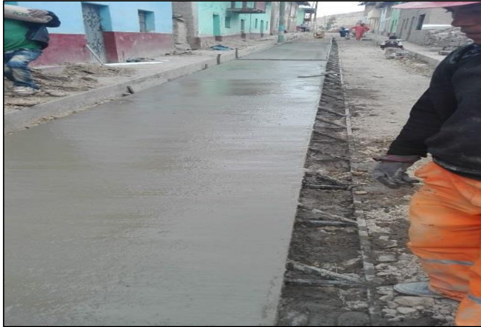
Figura 15M: Acabado de Concreto en Pavimento Rígido. (Tradicional) (Fuente: BDC Ingeniería & Construcción E.I.R.L.)
