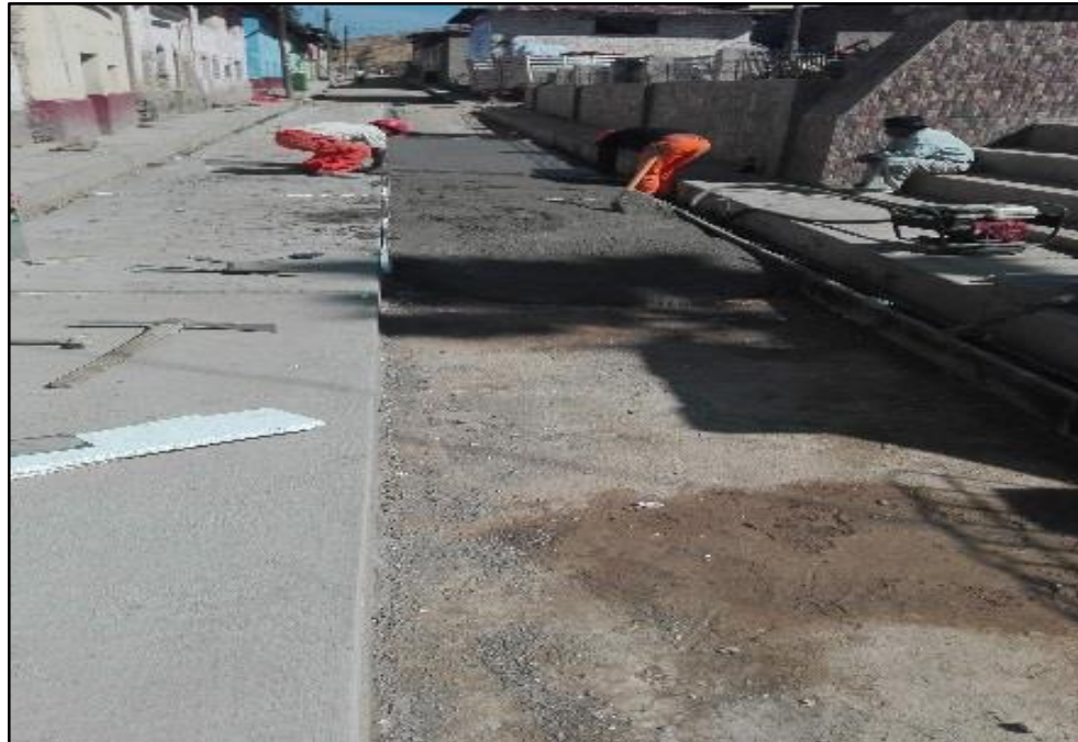
Figura 26M: Vaciado, Vibrado y Regleado del Concreto en Pavimento Rígido. (Lean Construction) (Fuente: BDC Ingeniería & Construcción E.I.R.L.)
