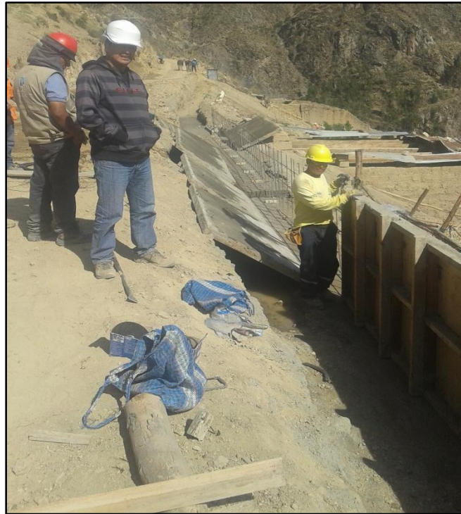
Figura 44M: Encofrado e Izado de Fierros en Muros de Contención. (Tradicional) (Fuente: BDC Ingeniería & Construcción E.I.R.L.)
