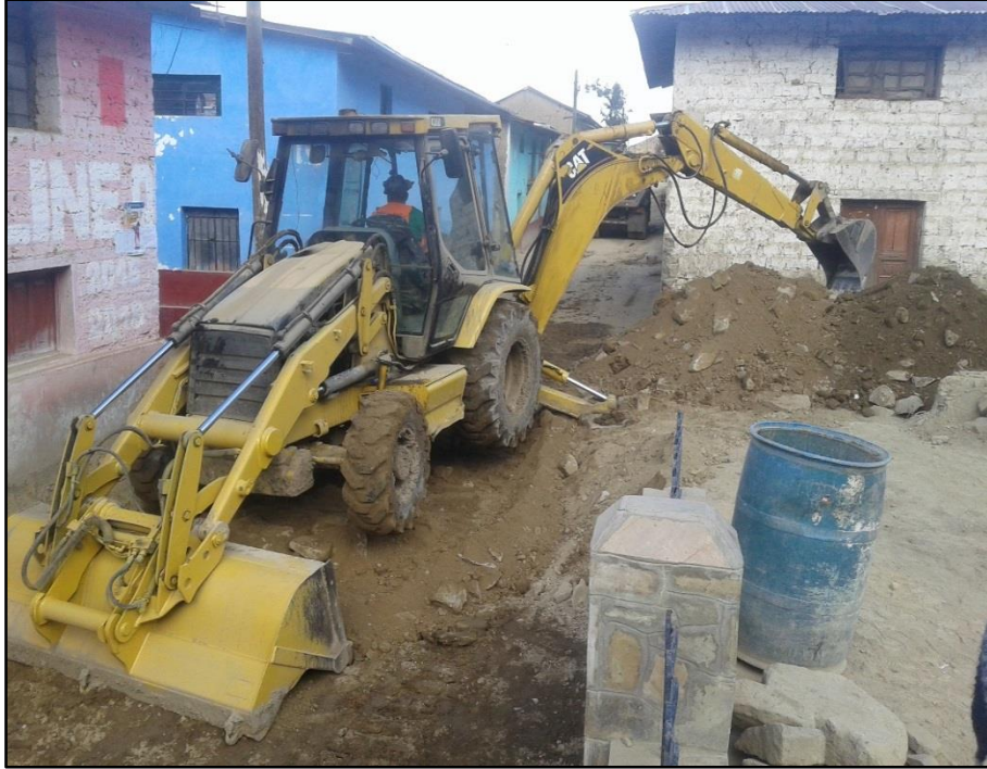
Figura 5M: Excavación y Corte de Terreno. (Fuente: BDC Ingeniería & Construcción E.I.R.L.)
