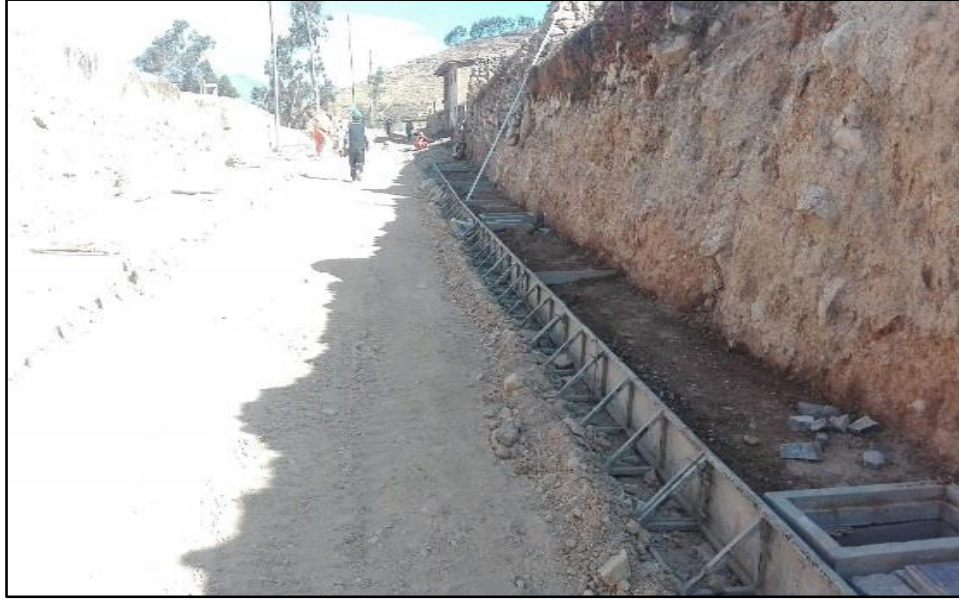
Figura 35M: Encofrado Metálico en Veredas. (Tradicional) (Fuente: BDC Ingeniería & Construcción E.I.R.L.)
