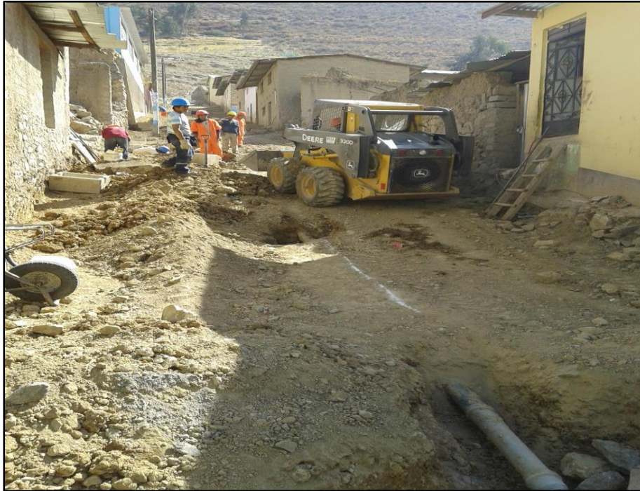
Figura 6M: Excavaciones para las Instalaciones de los Sistemas Básicos. (Fuente: BDC Ingeniería & Construcción E.I.R.L.)
