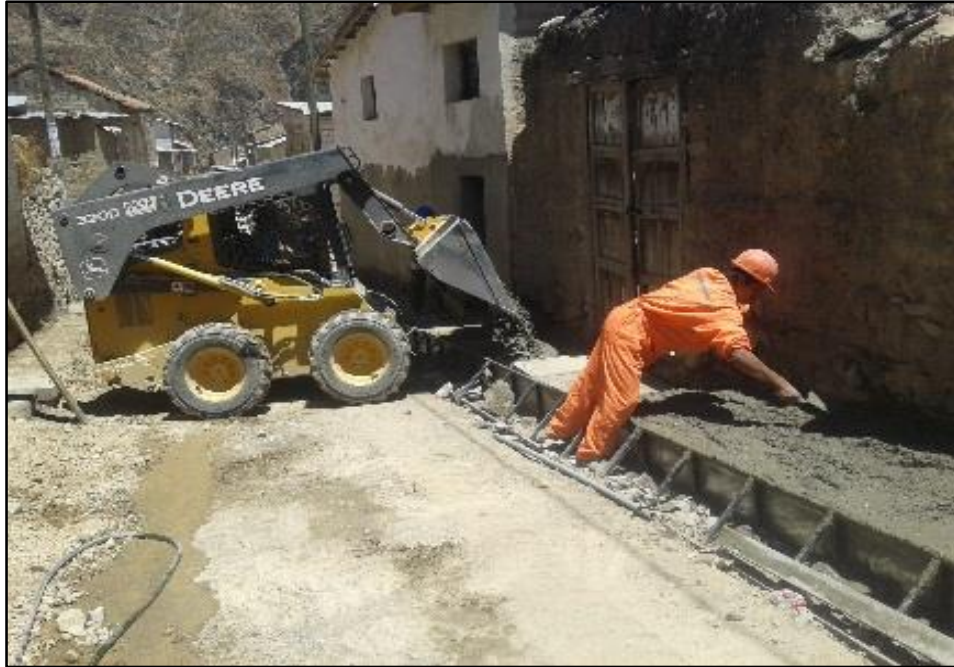
Figura 39M: Vaciado del Concreto en Veredas con Minicargador. (Lean Construction) (Fuente: BDC Ingeniería & Construcción E.I.R.L.)
