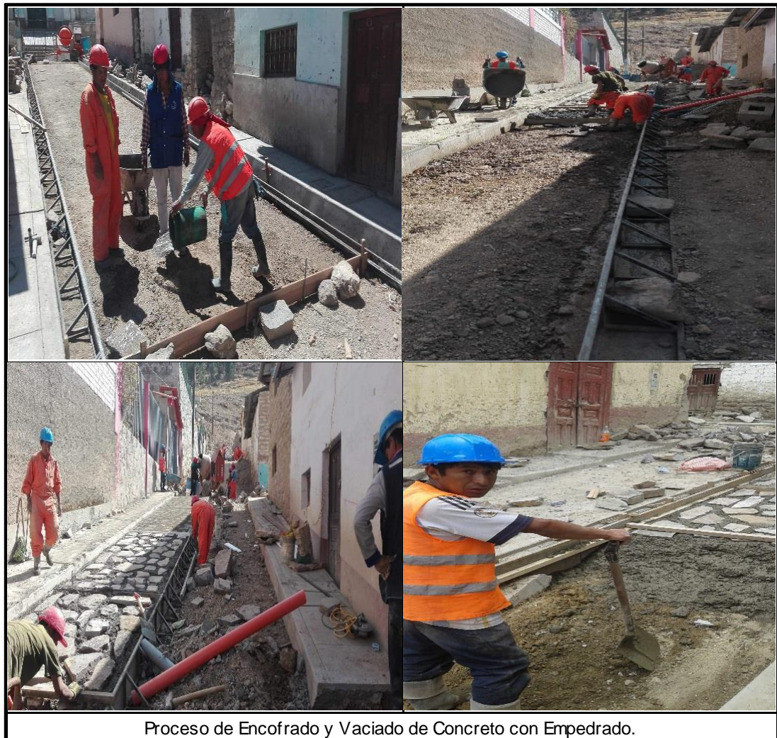
Figura 41: Vista de Trabajos de Pavimento Rígido con Concreto F'c=175\text{kg/cm}^2 , mas Empedrado del 60%, Programación Tradicional.
