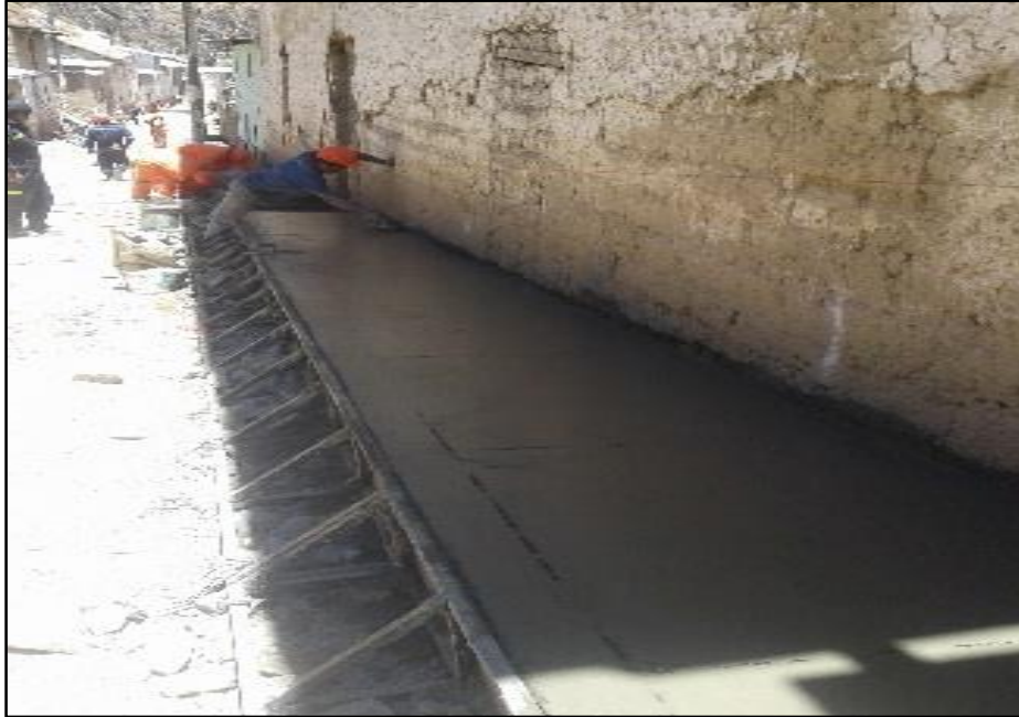
Figura 37M: Acabado en Veredas. (Tradicional) (Fuente: BDC Ingeniería & Construcción E.I.R.L.)
