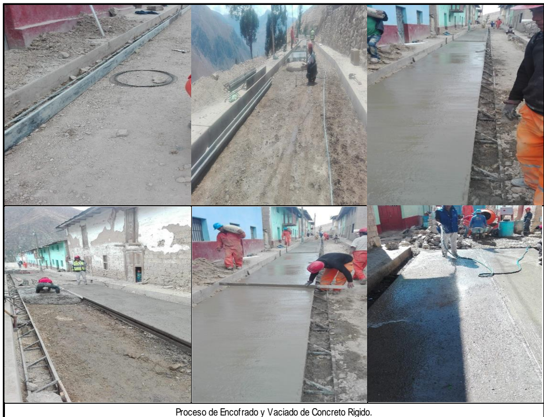
Figura 40: Vista de Trabajos de Pavimento Rígido con Concreto F'c=210\text{kg/cm}^2 , Programación Tradicional.
