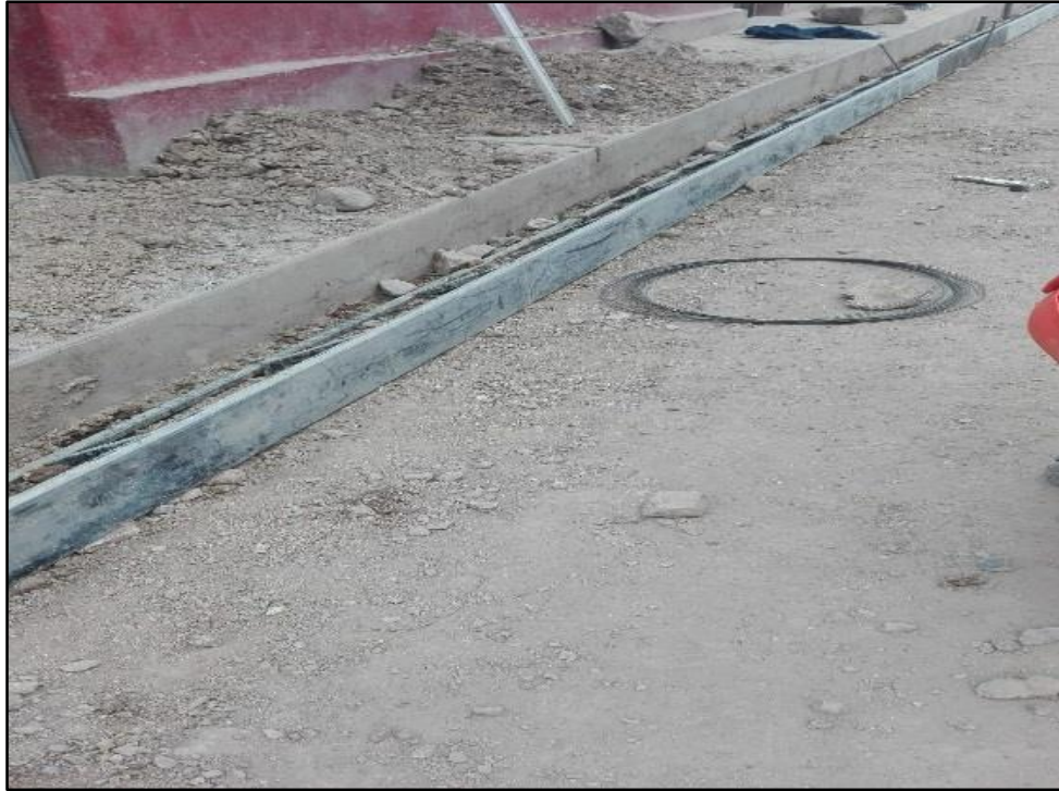
Figura 13M: Encofrado Metálico en Pavimento Rígido. (Tradicional) (Fuente: BDC Ingeniería & Construcción E.I.R.L.)
