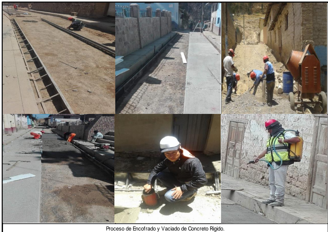
Figura 42: Vista de Trabajos de Pavimento Rígido con Concreto F'c=210\text{kg/cm}^2 , Programación Lean Construction. (Fuente: Obra de Pistas y Veredas )
