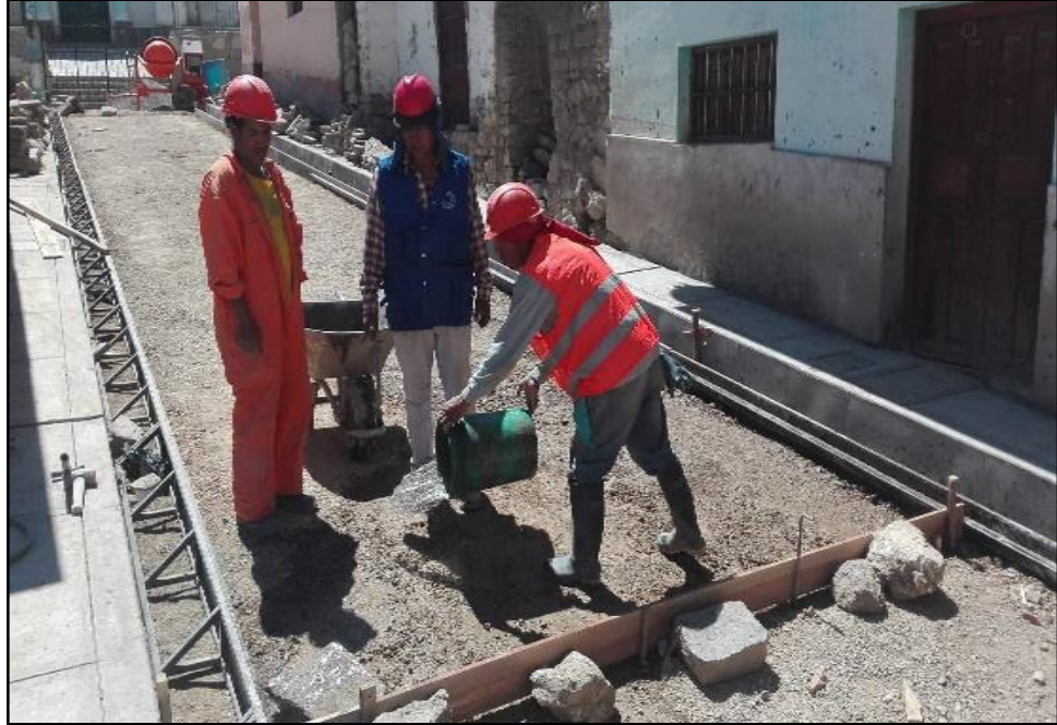
Figura 19M: Trabajos Preliminares al Vaciado del Concreto. (Tradicional) (Fuente: BDC Ingeniería & Construcción E.I.R.L.)
