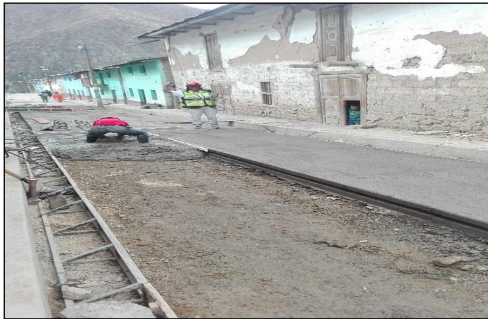
Figura 16M: Vaciado del Concreto en Pavimento Rígido. (Tradicional) (Fuente: BDC Ingeniería & Construcción E.I.R.L.)
