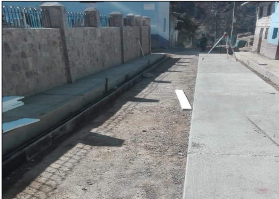
Figura 24M: Limpieza Inicial anterior al Vaciado del Concreto. (Lean Construction) (Fuente: BDC Ingeniería & Construcción E.I.R.L.)
