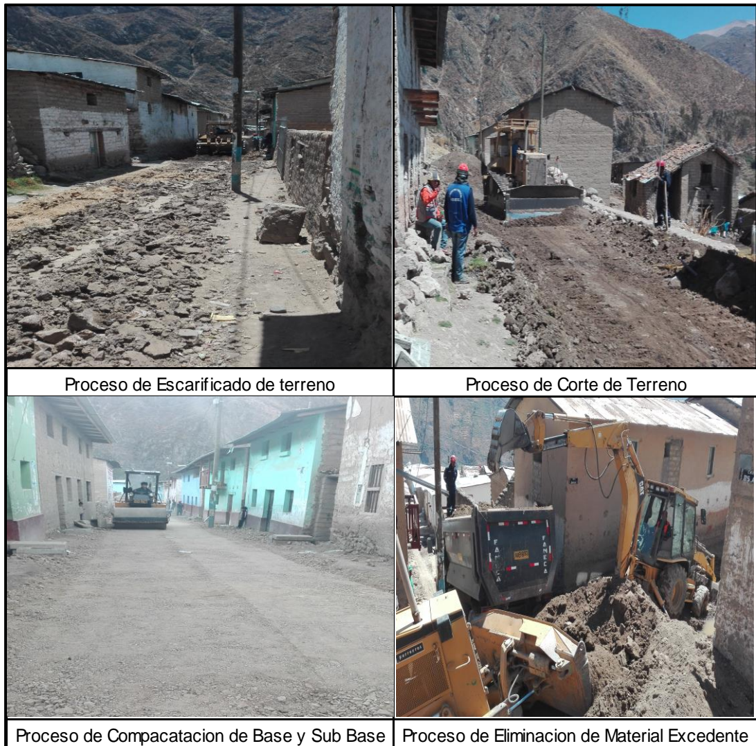
Figura 39: Vista de Trabajos de Movimiento de Tierras.
