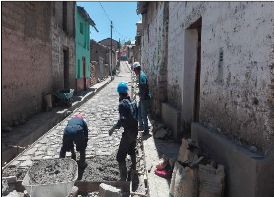
Figura 32M: Vaciado del Concreto en Pavimento con Empedrado. (Lean Construction) (Fuente: BDC Ingeniería & Construcción E.I.R.L.)
