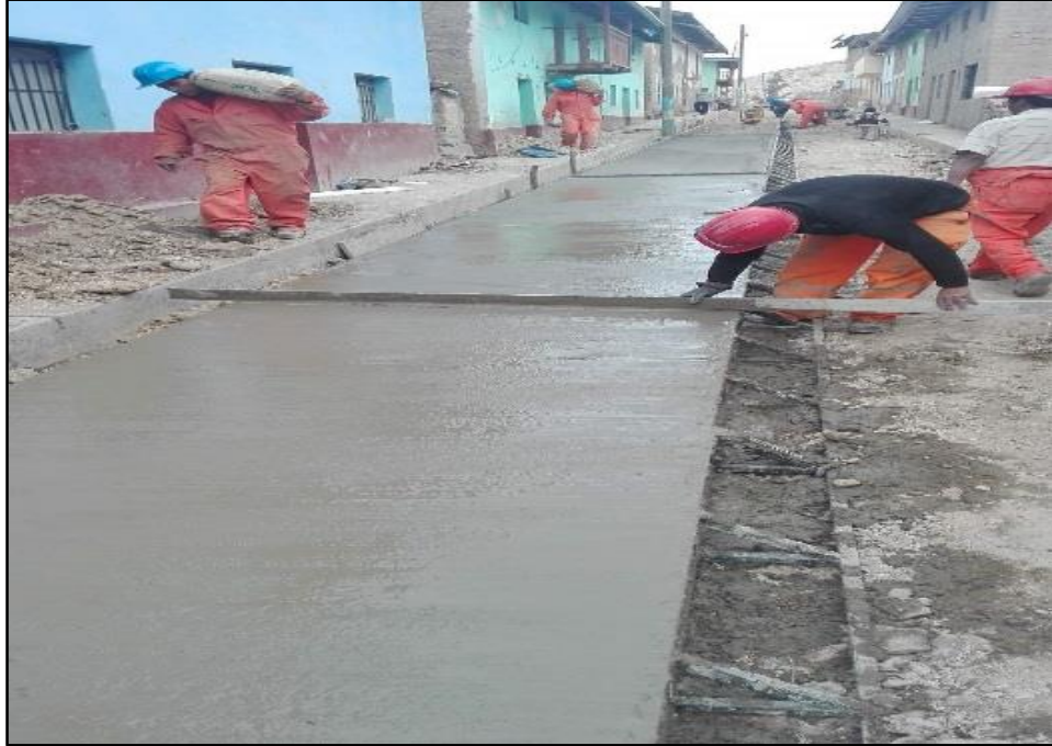
Figura 17M: Regleado del Concreto y Traslado de Materiales para Mezcla. (Tradicional) (Fuente: BDC Ingeniería & Construcción E.I.R.L.)
