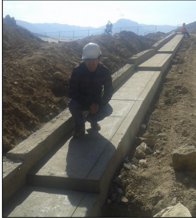
Figura 43M: Trabajos de Muro de Contención y Veredas. (Tradicional) (Fuente: BDC Ingeniería & Construcción E.I.R.L.)
