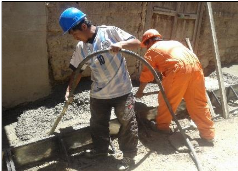
Figura 40M: Vaciado y Vibrado del Concreto en Veredas. (Lean Construction) (Fuente: BDC Ingeniería & Construcción E.I.R.L.)
