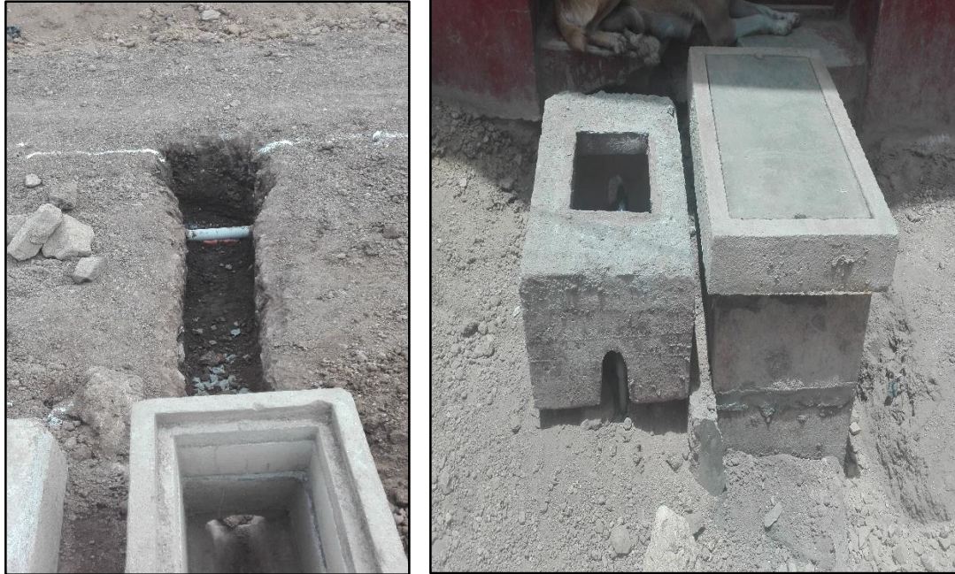
Figura 9M: Reposición de Cajas Domiciliarias. (Fuente: BDC Ingeniería & Construcción E.I.R.L.)
