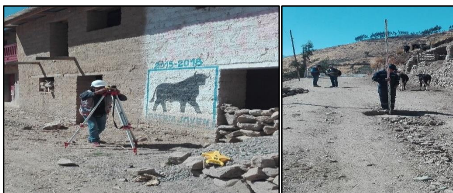
Figura 38: Vista del Trazo y Replanteo.
