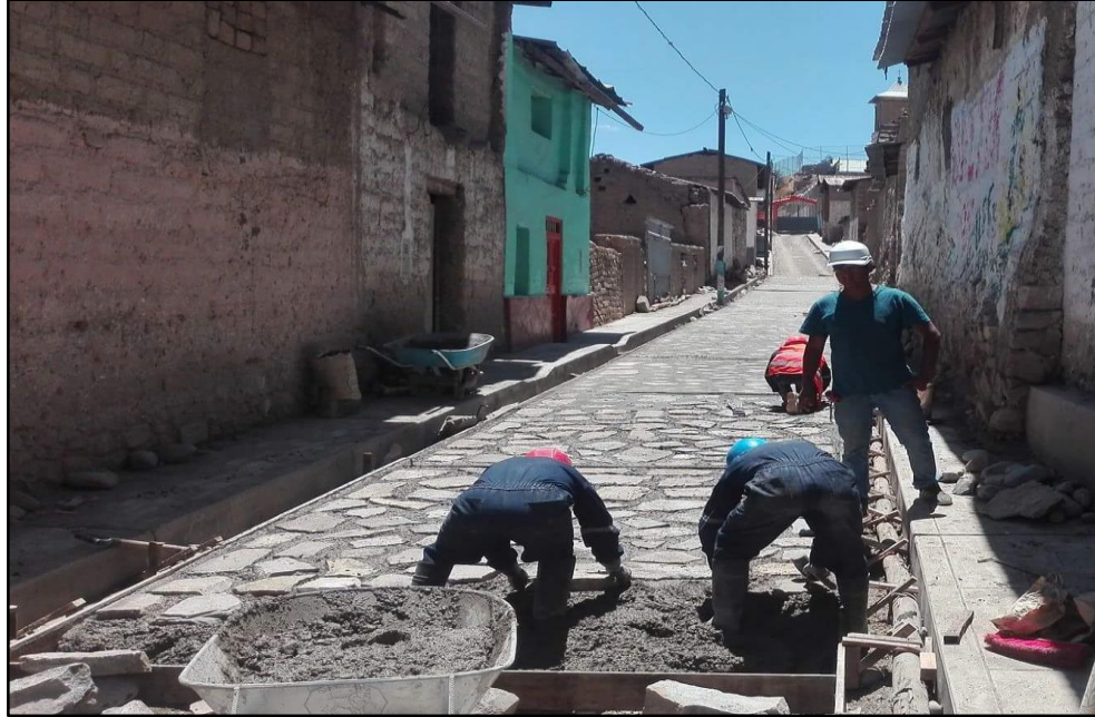
Figura 33M: Acabado y Vaciado de Pavimentos con Empedrado. (Lean Construction) (Fuente: BDC Ingeniería & Construcción E.I.R.L.)
