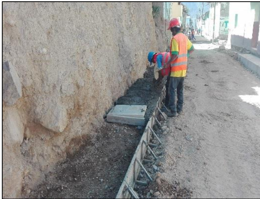
Figura 36M: Vaciado del Concreto en Veredas. (Tradicional) (Fuente: BDC Ingeniería & Construcción E.I.R.L.)
