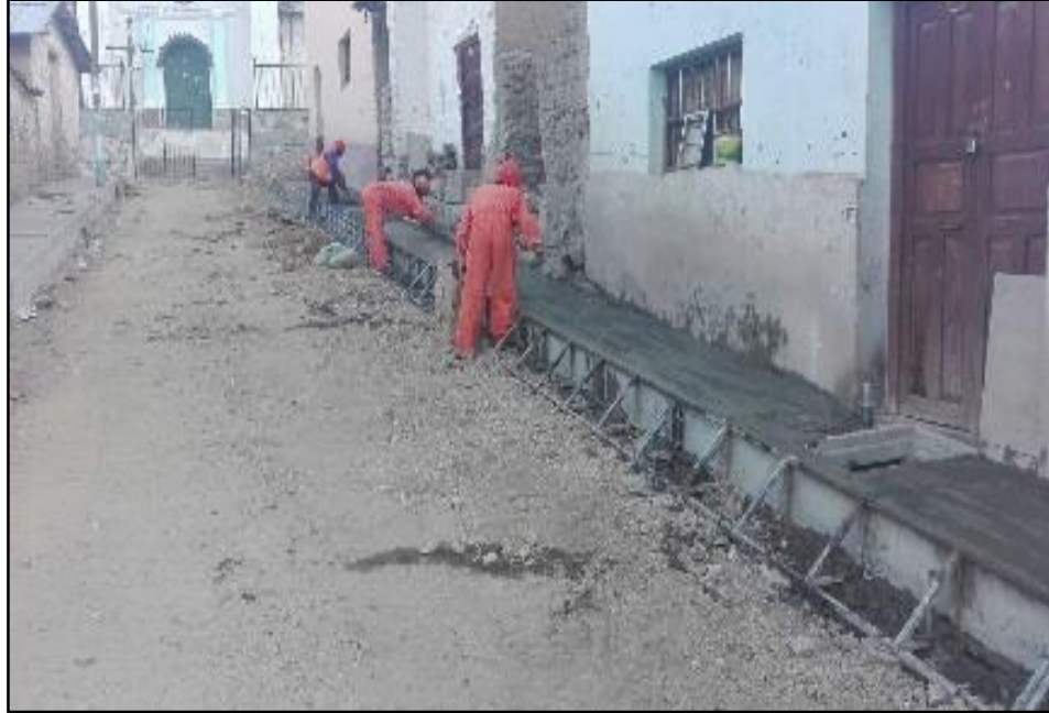
Figura 41M: Acabados en Veredas. (Lean Construction) (Fuente: BDC Ingeniería & Construcción E.I.R.L.)
