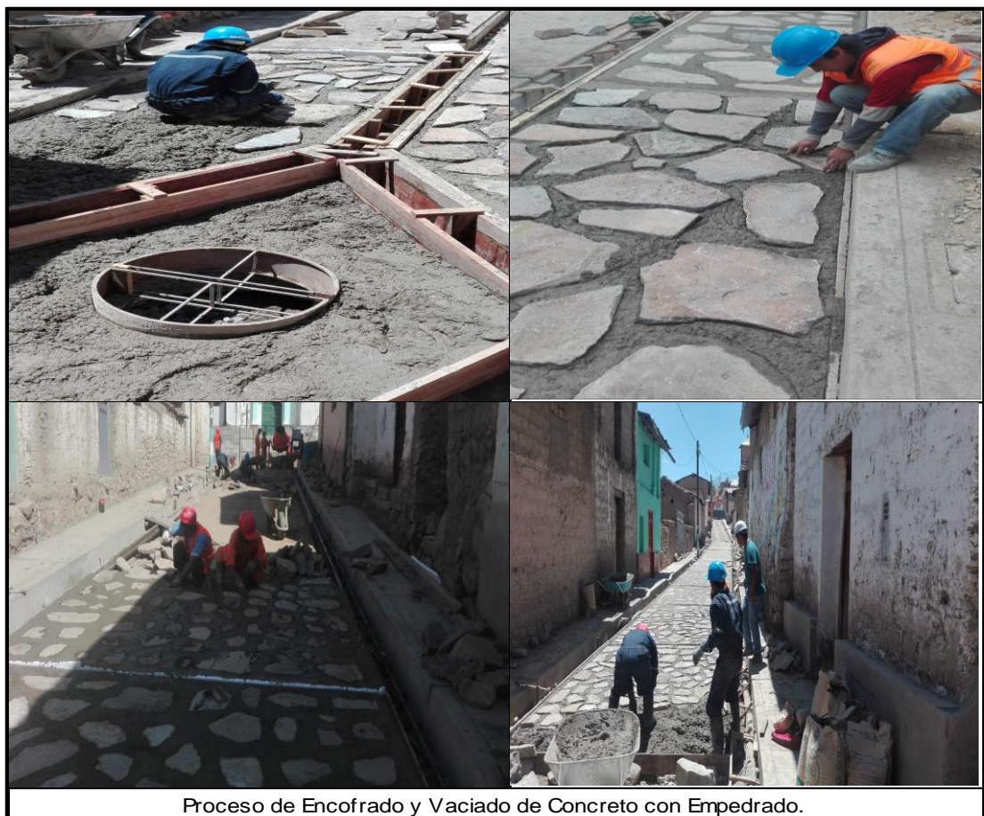
Figura 43: Vista de Trabajos de Pavimento Rígido con Concreto F'c=175\text{kg/cm}^2 , mas Empedrado del 60%, Programación Lean Construction.
