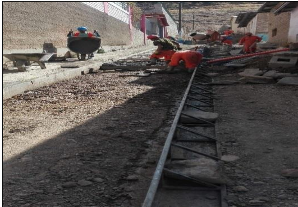
Figura 20M: Vaciado del Concreto en Pavimentos con Empedrado. (Tradicional) (Fuente: BDC Ingeniería & Construcción E.I.R.L.)
