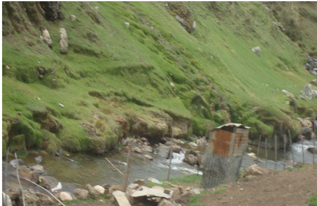
FOTO 04 Letrina con desagua al rio Tingo
