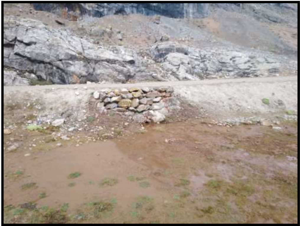
Fotografía N°31: Filtración y salida de las aguas ácidas
