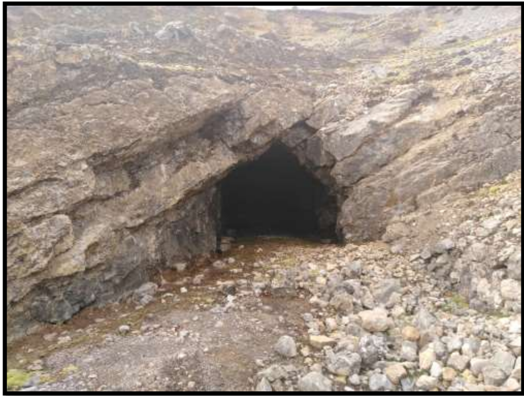
Fotografía N°11: Se observa una bocamina que falta hacer su cierre
