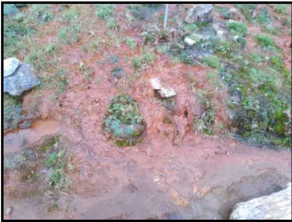
Fotografía N°24: Filtración de las aguas ácidas
