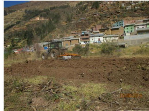
Fig 4 Desterronado del terreno
