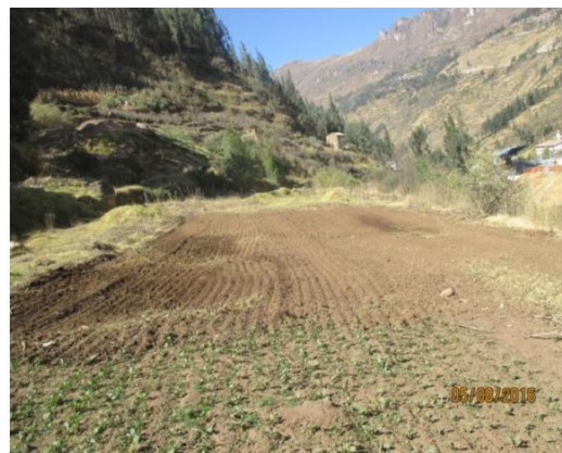
Fig 6 Terreno desterronado y nivelado
