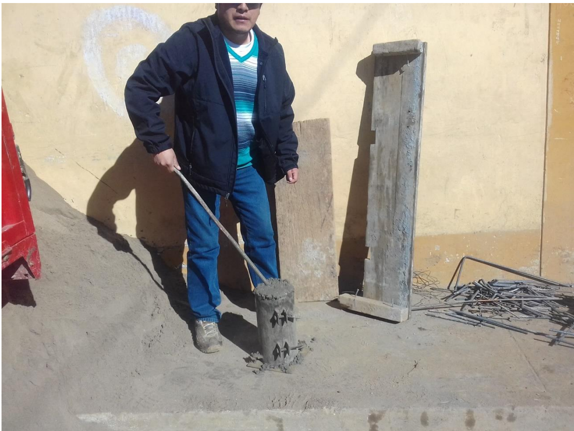
FOTOGRAFIA 08: FABRICACIÓN DE LAS PROBETAS DE CONCRETO.
