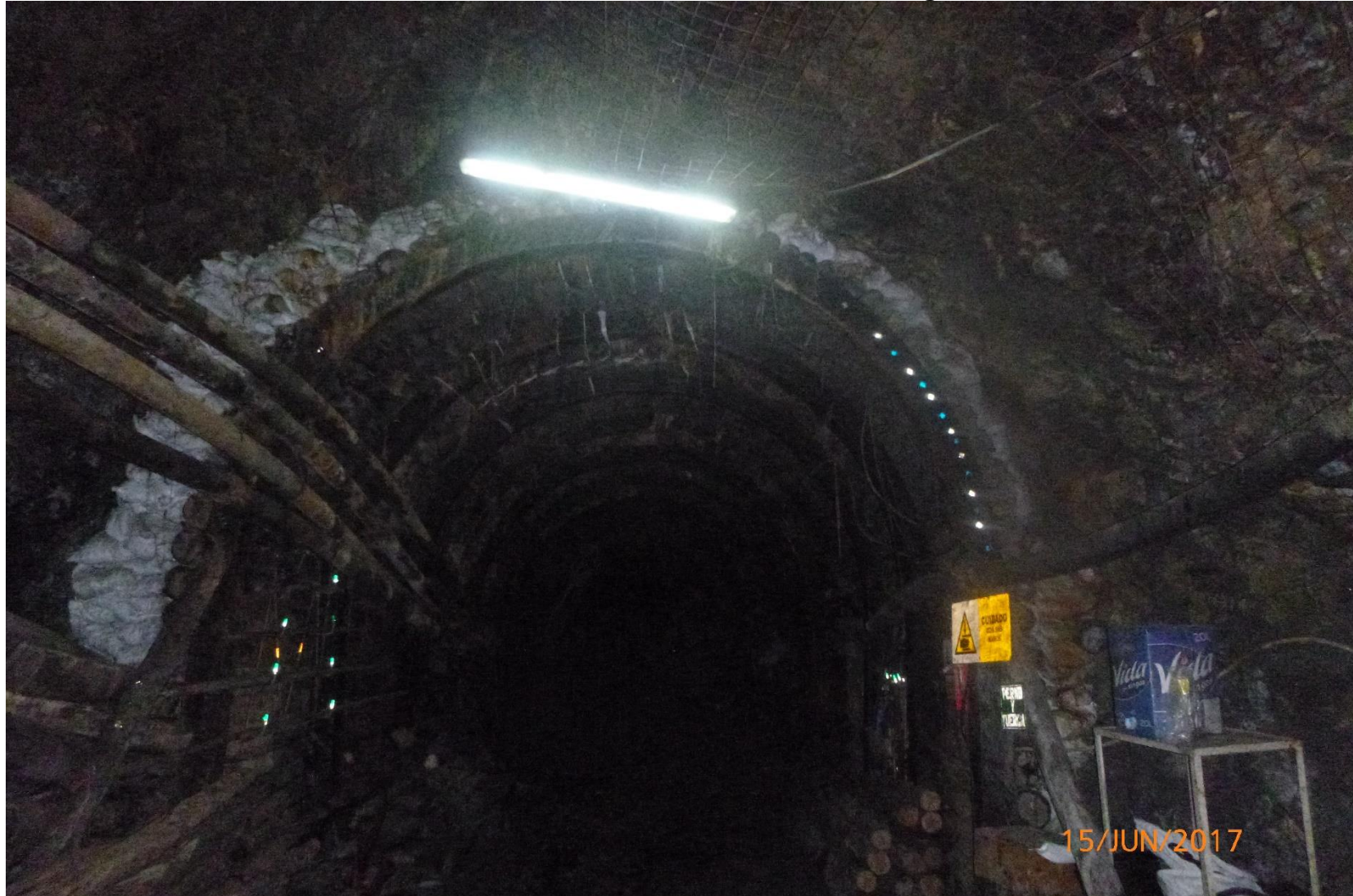
Foto 2.1: labor sostenimiento con cimbras rígidas
