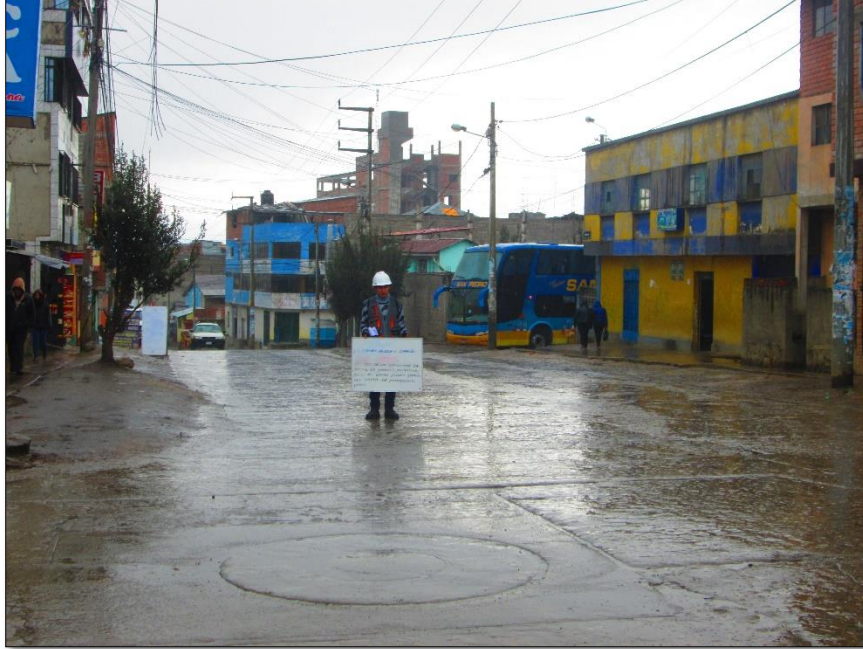
Imagen 1056. 2da. cuadra (Intersección Av. Daniel Alcides Carrión con Av. 6 de Diciembre) – No existe ningún tipo de señalización. FUENTE: Propia
