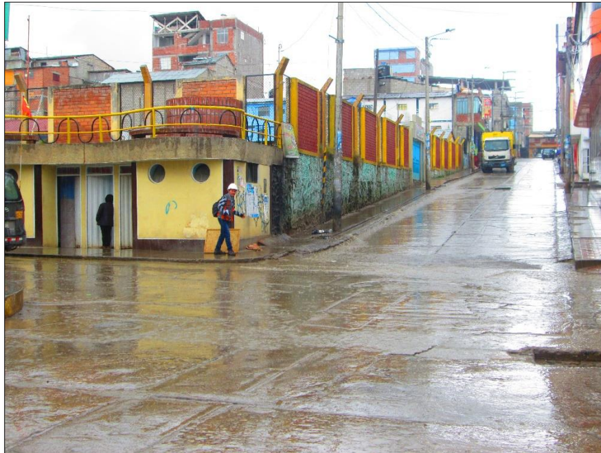
Imagen 1078. 3ra cuadra (Intersección Av. Daniel Alcides Carrión con Av. Ramón Castilla) – No existe ningún tipo de señalización. FUENTE: Propia
