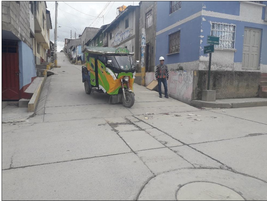
Imagen 124. 9na cuadra (Intersección Av. Daniel Alcides Carrión con Calle Libertad) –No Existe Marcas en el pavimento. FUENTE: Propia
