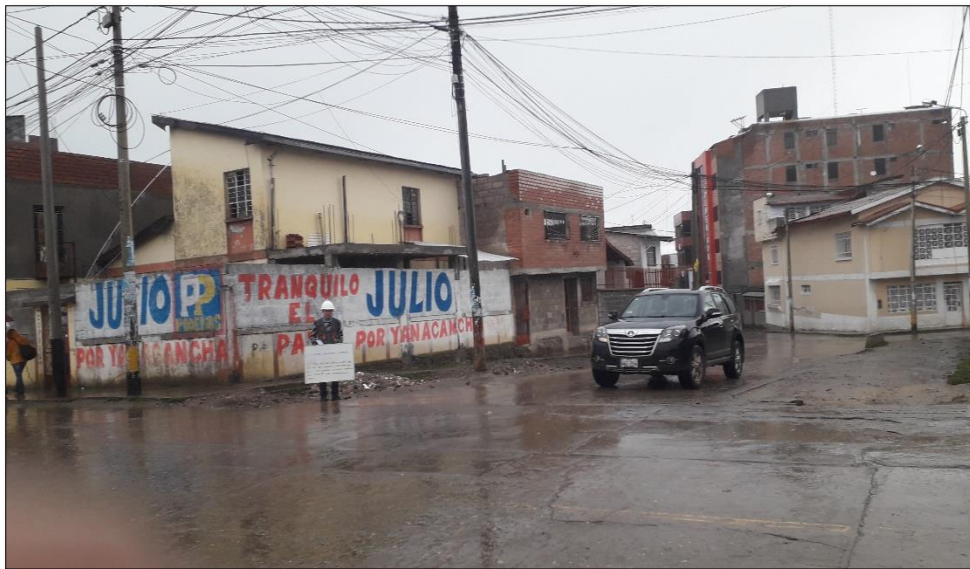
Imagen 1045. 1ra cuadra de (Intersección Av. Daniel Alcides Carrión con Jr. Lima) – No existe ningún tipo de señalización. FUENTE: Propia
