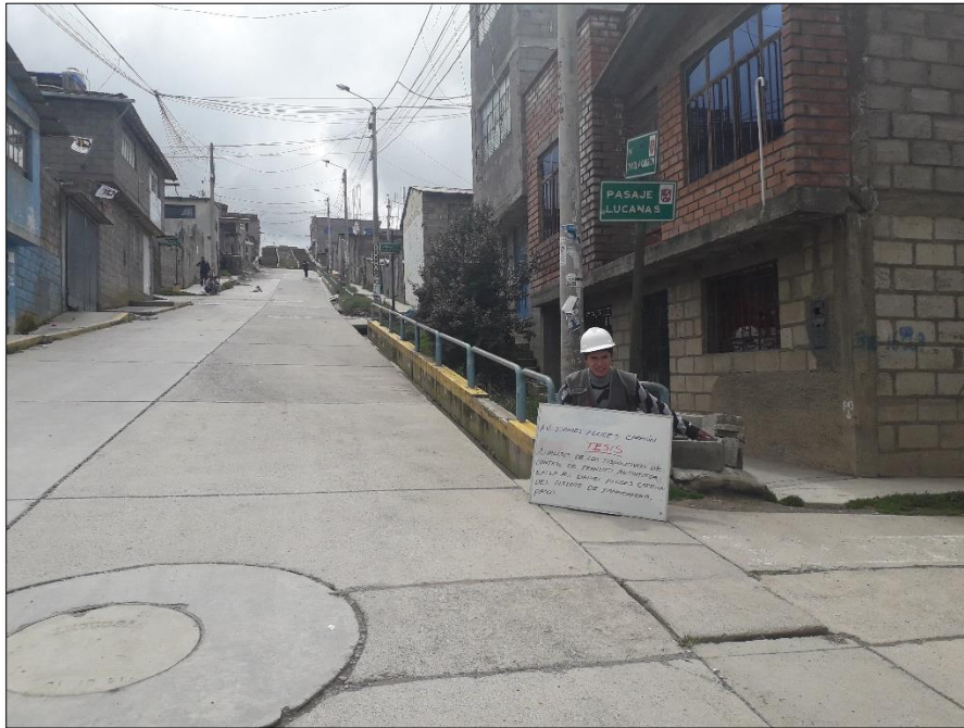
Imagen 128. 10ma cuadra (Intersección Av. Daniel Alcides Carrión con pasaje Lucanas) – Existe señalización informativa en buen estado. FUENTE: Propia
