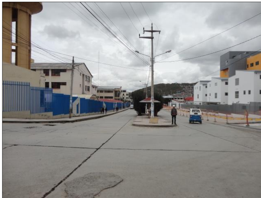
Imagen 119. 6ta cuadra (Intersección Av. Daniel Alcides Carrión con Av. La Cultura) – No existe ningún tipo de señalización. FUENTE: Propia
