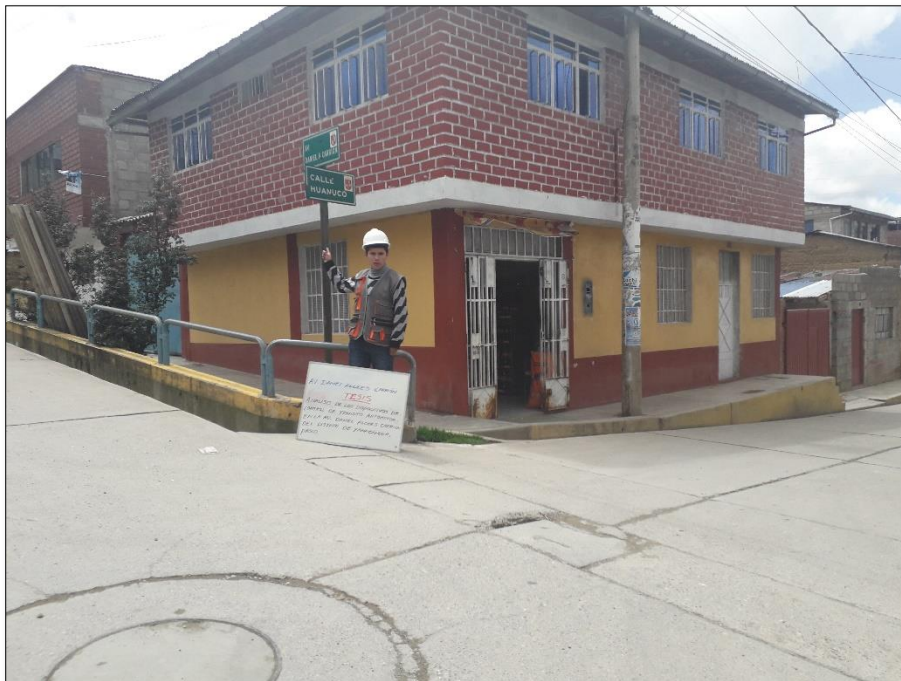
Imagen 127. 9na cuadra (Intersección Av. Daniel Alcides Carrión con Calle Huánuco) – Existe señalización informativa en regular estado. FUENTE: Propia
