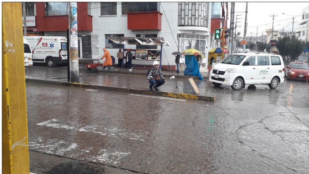
Imagen 111. 4ta cuadra (Intersección Av. Daniel Alcides Carrión con Av. Los Próceres) – Se puede marcar en el pavimento en mal estado. FUENTE: Propia
