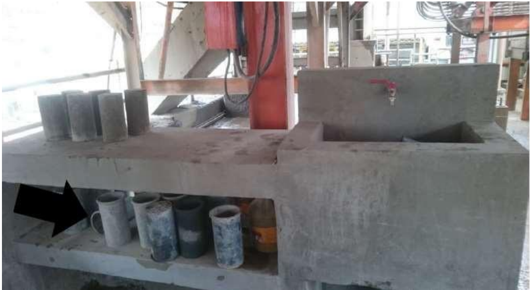
8 unidades de probetas para muestreo de concreto en superficie (buen estado).
