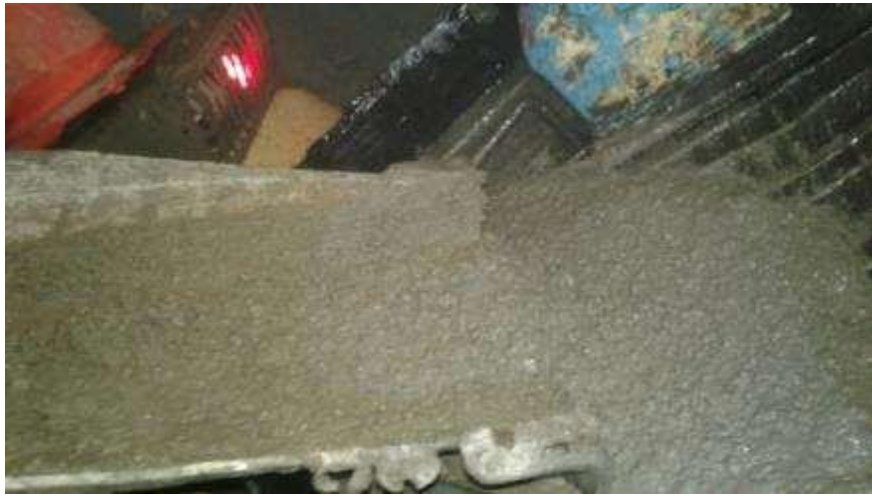
Lanzado De Concreto
