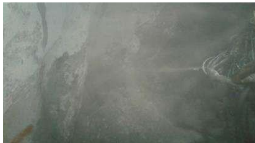
Lanzado De Concreto
