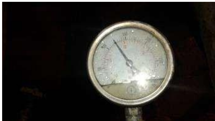
Manómetro Ubicado En El Pulmón De Aire
