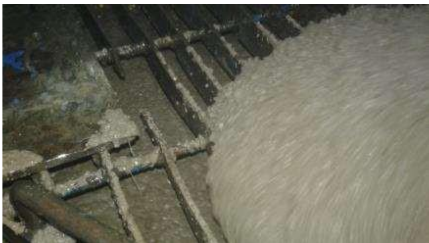
Lanzado De Concreto
