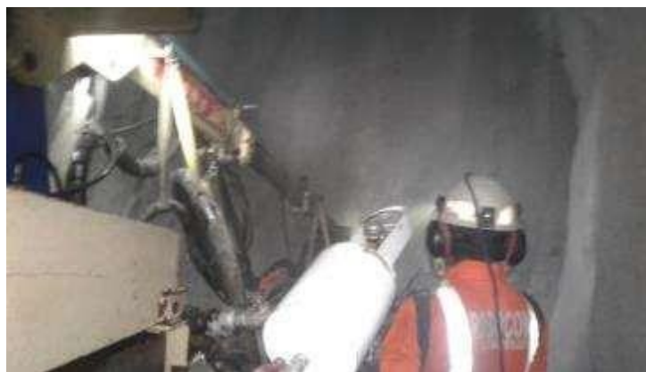
Operación de lanzamiento de shotcrete en frente de labor
