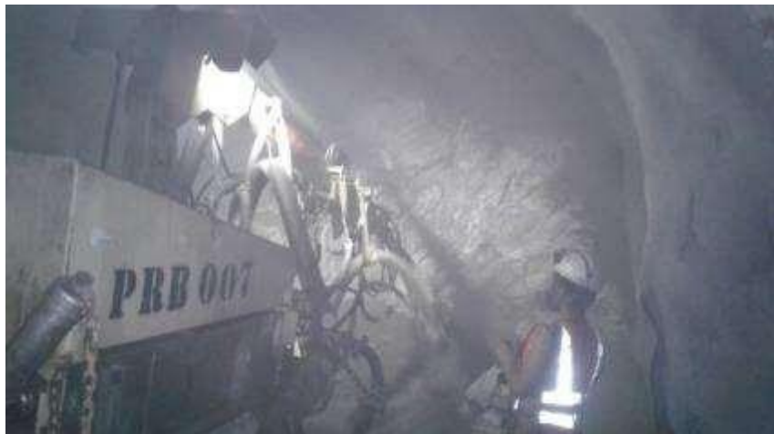
Lanzado De Concreto
