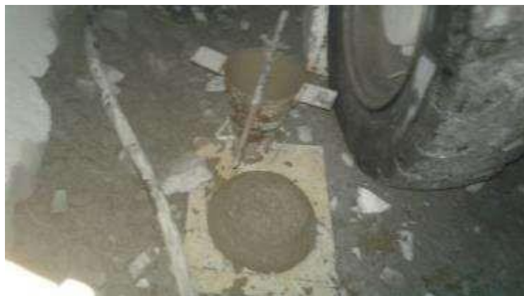
Medición De Slump En Mina
