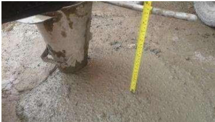
Medición De Slump En Planta
