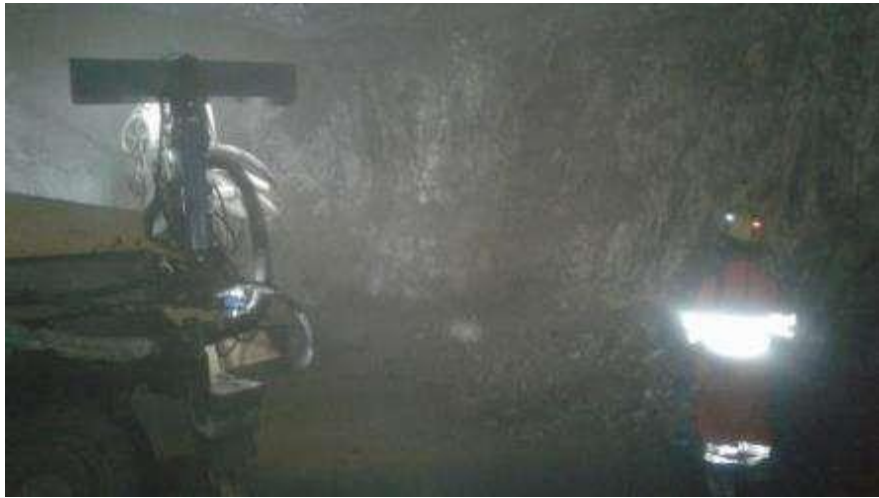
Lanzado De Concreto
