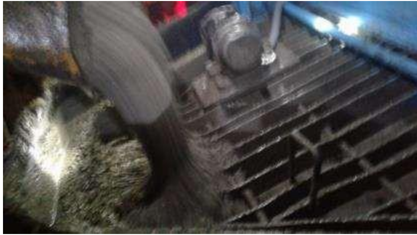
Vaciado Del Concreto En La Cuba Del Robot
