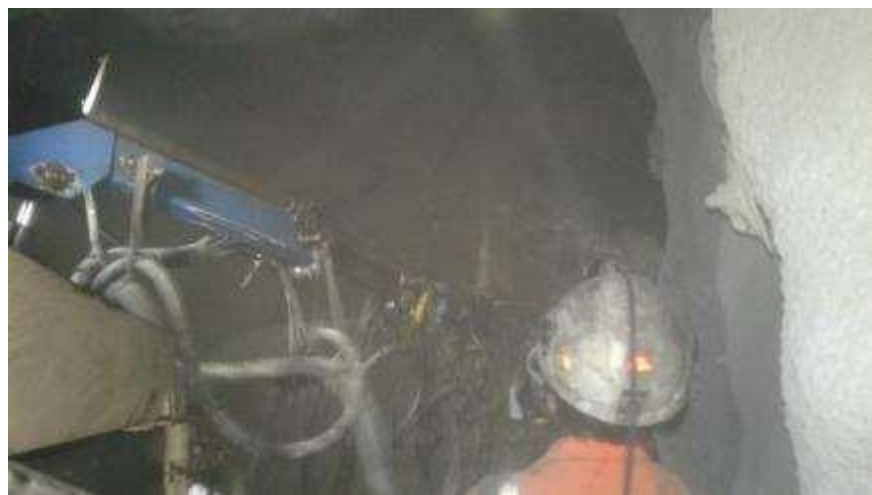
Lanzado De Concreto
