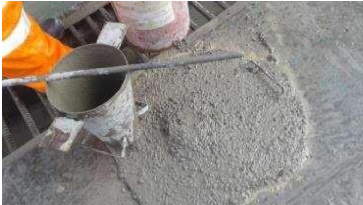
Medición De Slump En Planta
