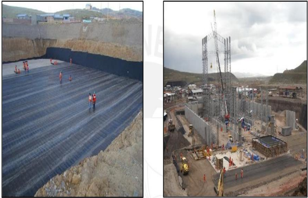
Figura 12. Mejoramiento de fundación en una planta de molienda y flotación
