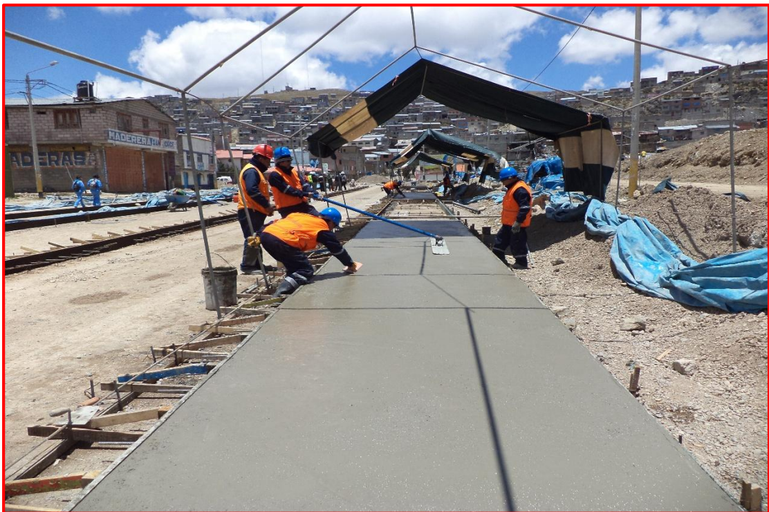
Se observa el acabado (peinado) del pavimento en la Av. Los Insurgentes
