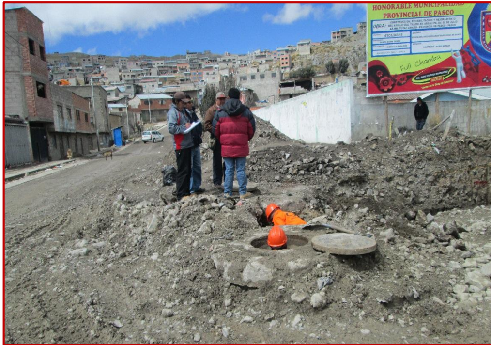
Se observa los trabajos preliminares en la Av. Los Insurgentes
