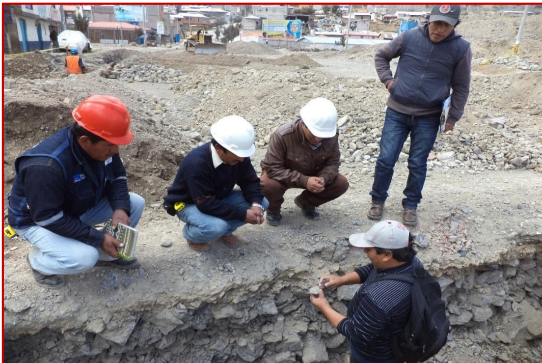
Estudios de suelos para la colocación de las geomallas en la Av. Los Insurgentes
