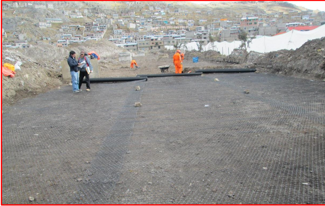
Tendido de las geomallas triaxiales, en la Av. Los insurgentes.
