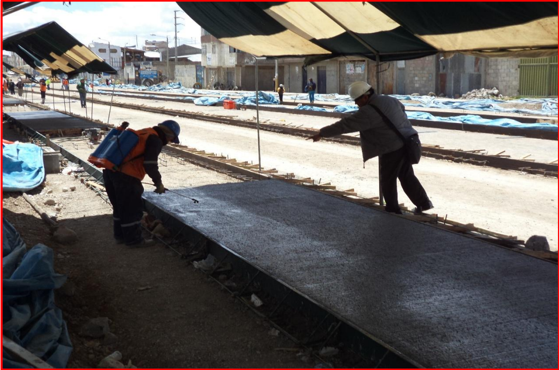
Se observa el acabado de la pavimentación, y así mismo el curado respectivo
