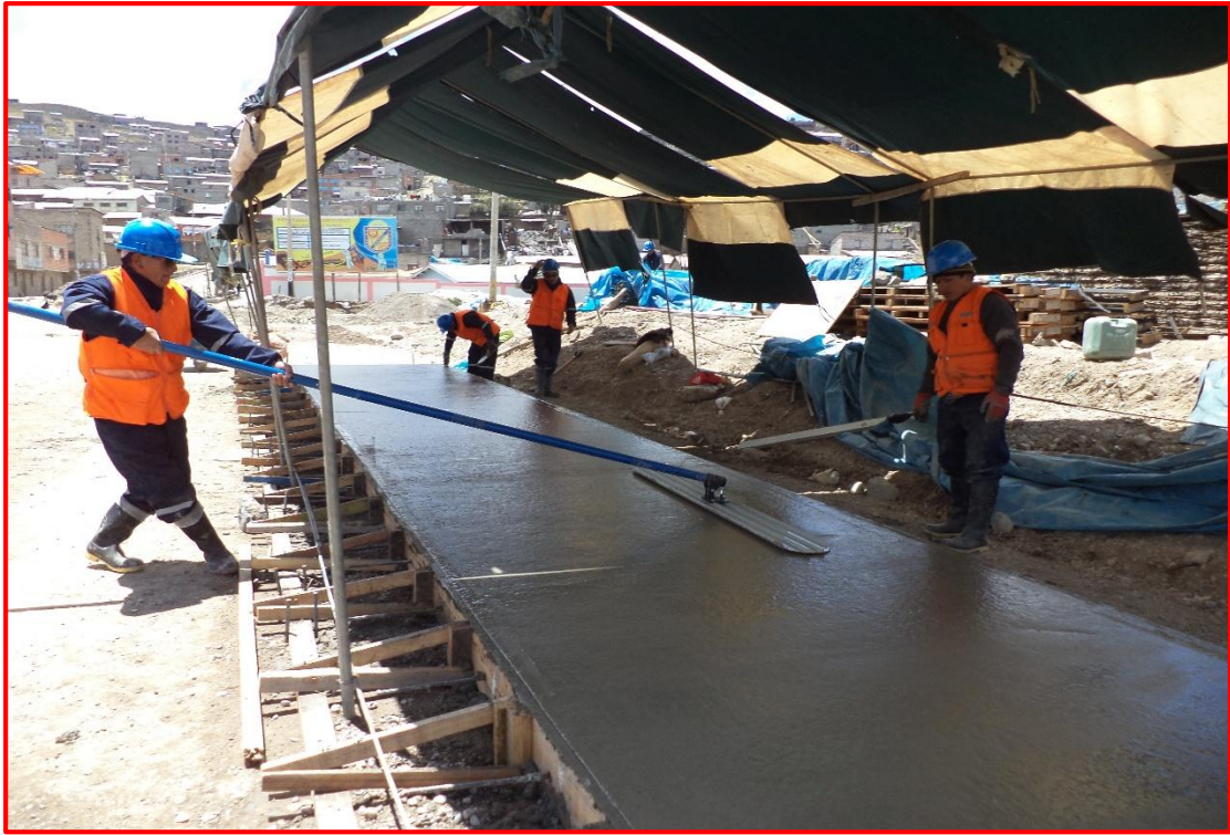
Se observa el acabado (peinado) del pavimento en la Av. Los Insurgentes
