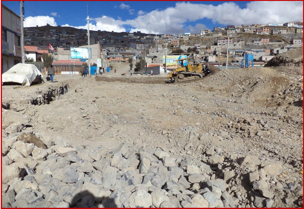
Se observa excavación de material para luego ser reemplazado por material de préstamo.
