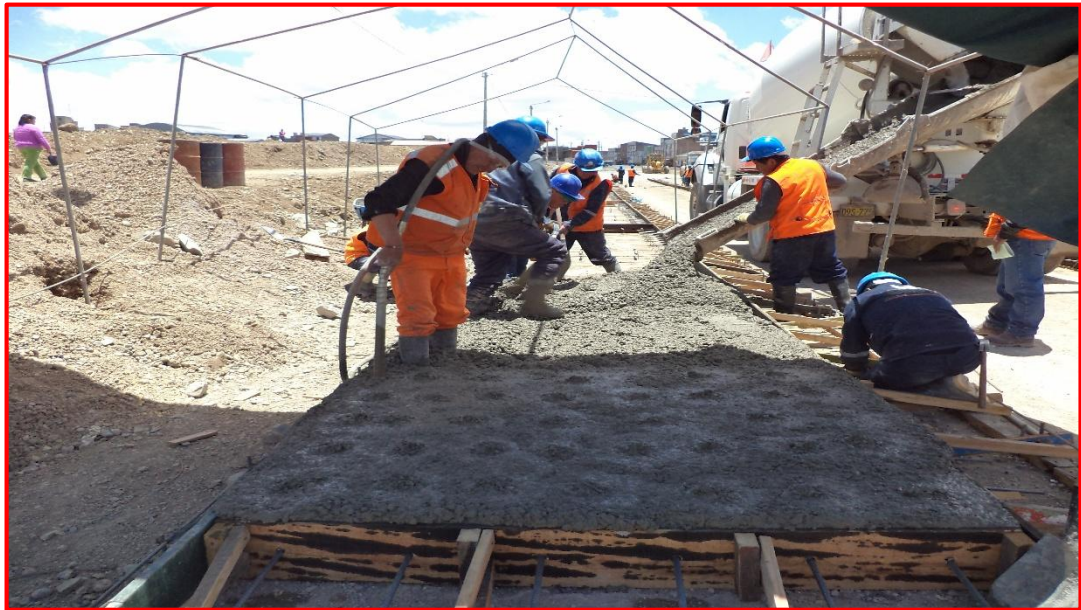
Se observa el vaciado del concreto en la pavimentación de la Av. Los Insurgentes
