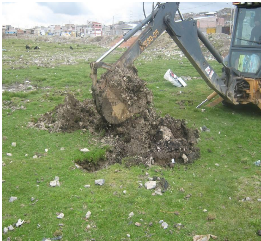
Inicio de los trabajos de excavación
