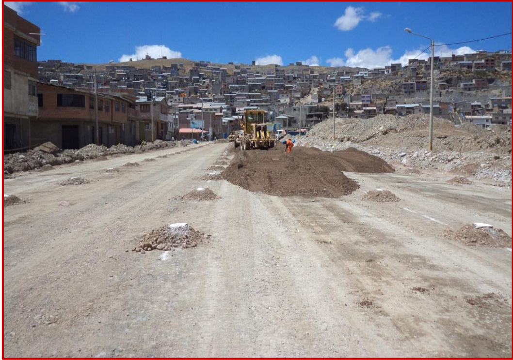
Se observa la Nivelación del material de reemplazo.
