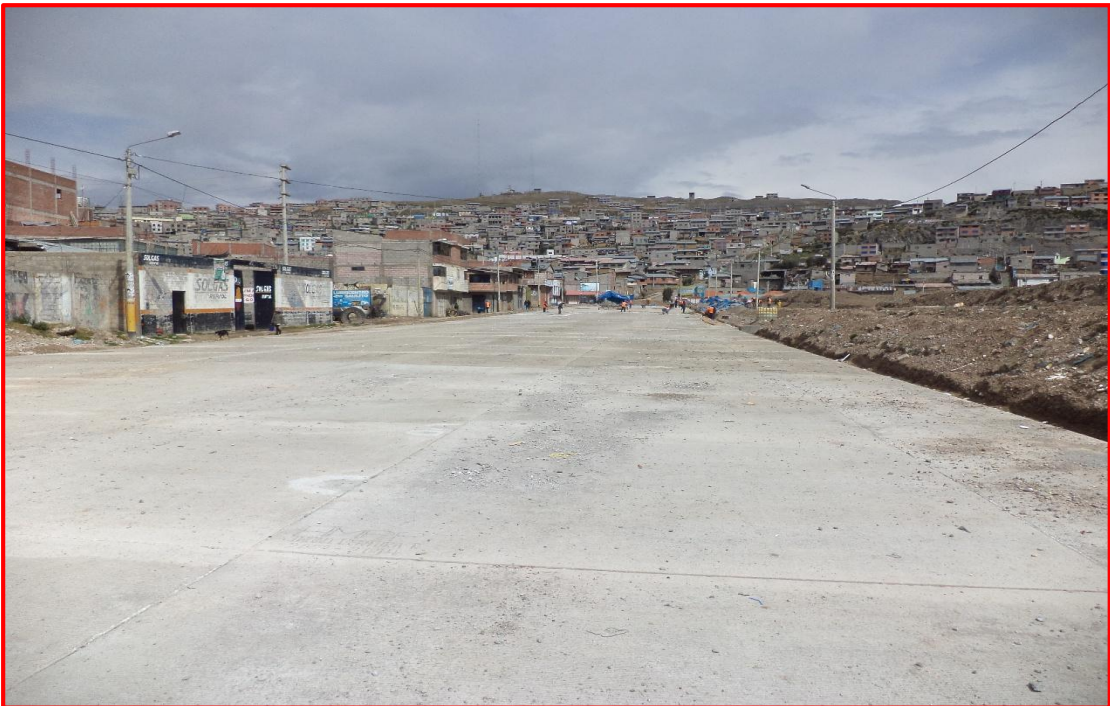
Se observa la culminación de la pavimentación de la Av. Los Insurgentes.
