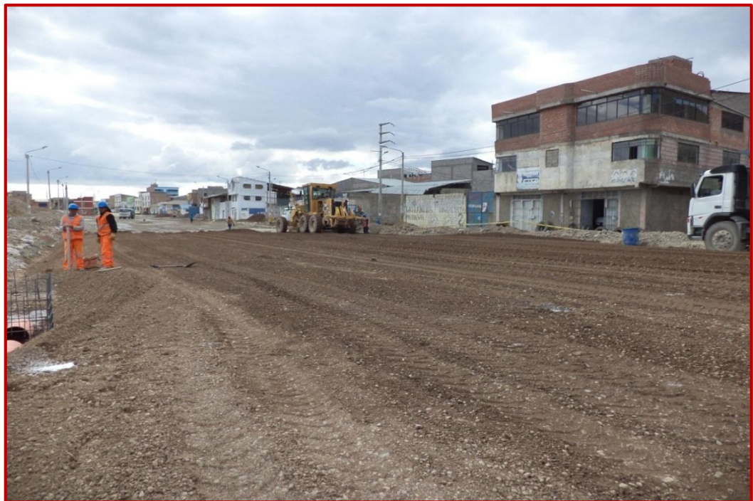
Se observa la colocación del material de reemplazo.
