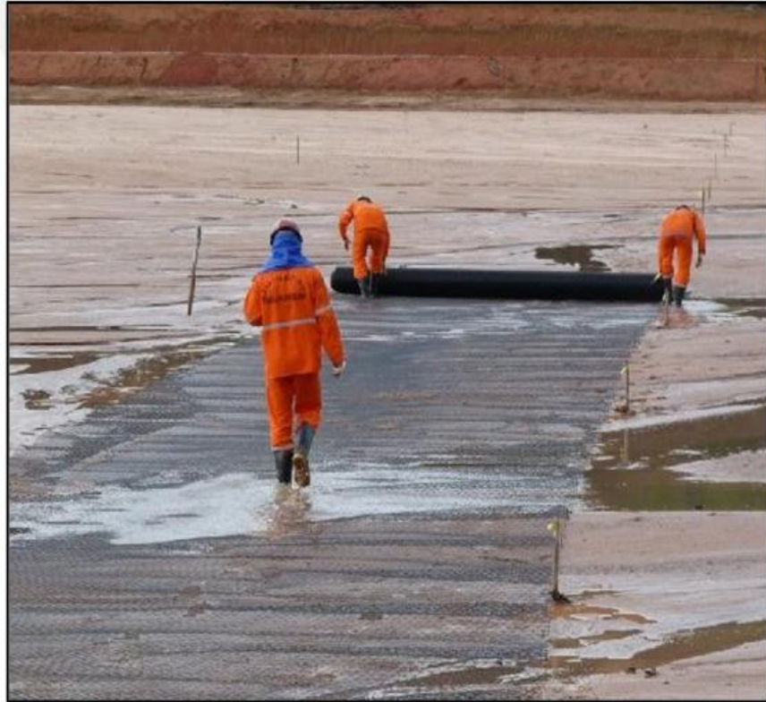
Figura 11. Colocación de geomallas para construcción de diques sobre bofedales
