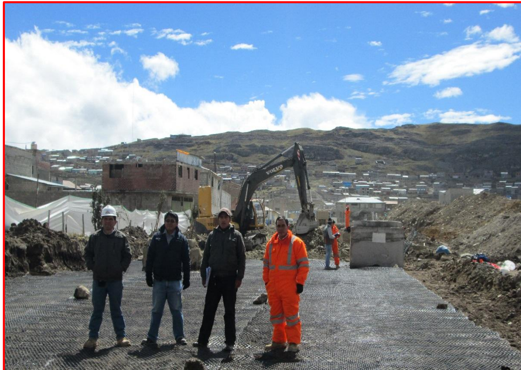
Se observa la geomalla triaxial colocada en la Av. Los Insurgentes
