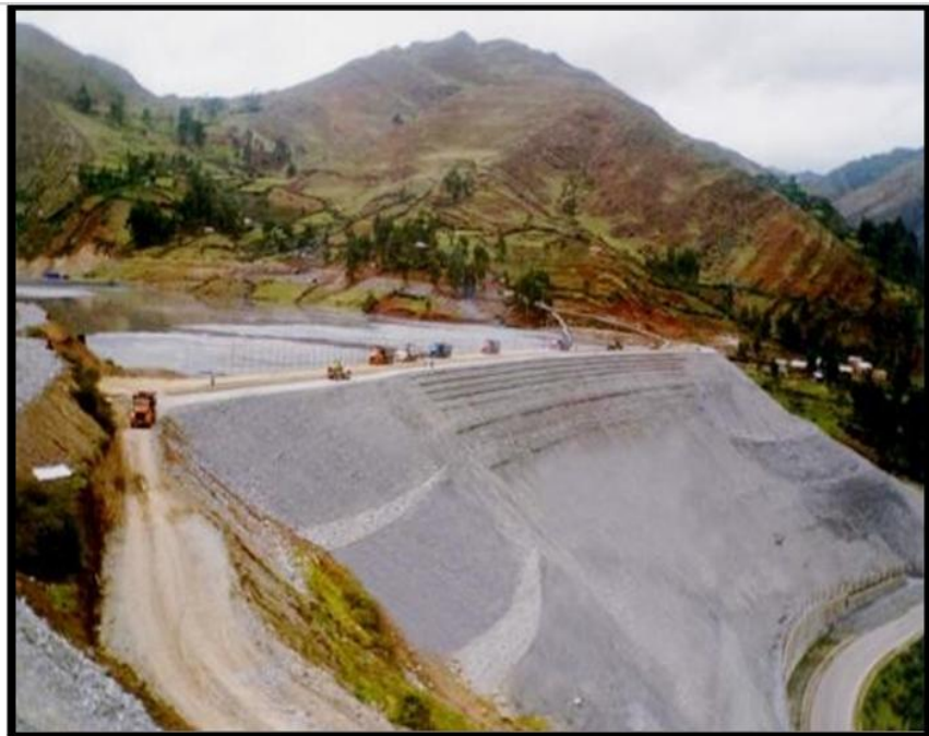
Figura 08. Talud de suelo reforzado
