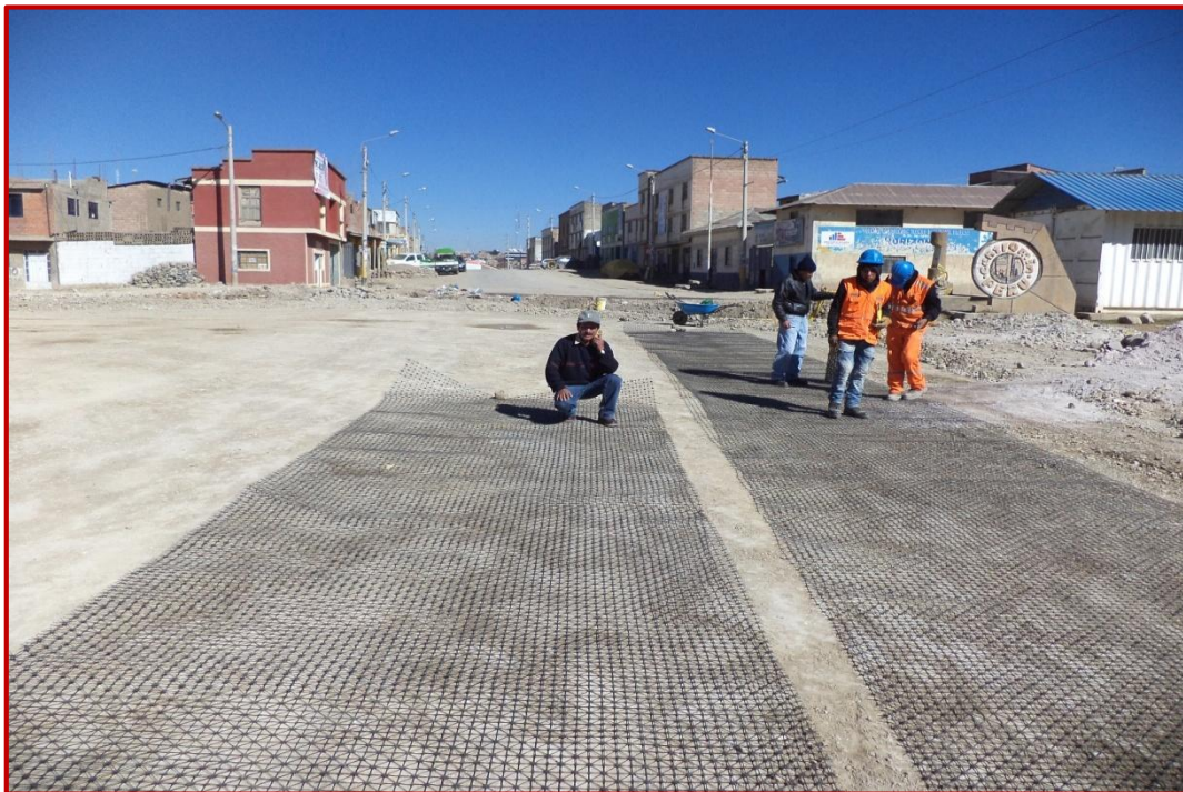
Tendido de las geomallas triaxiales, en la Av. Los insurgentes.
